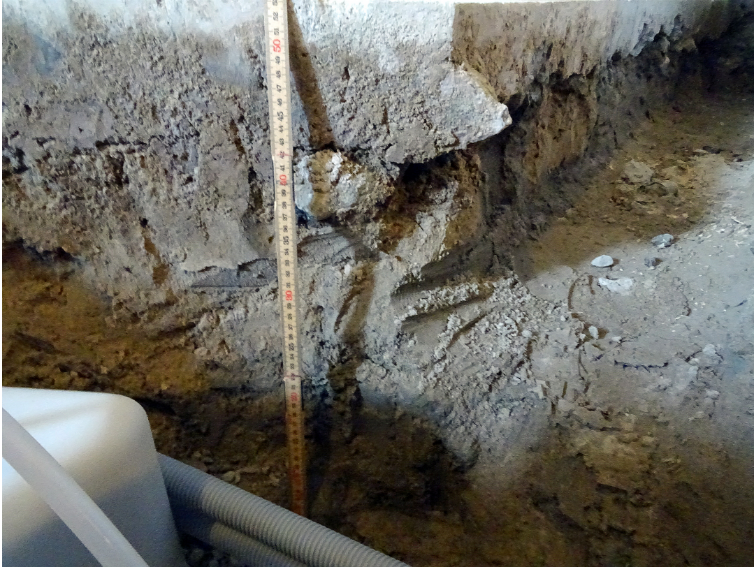
Figur 7. Schaktprofil vid pumpgropan. Under betongplattan följer ljusgrå sand ned till botten av gropan. Foto mot väst.
