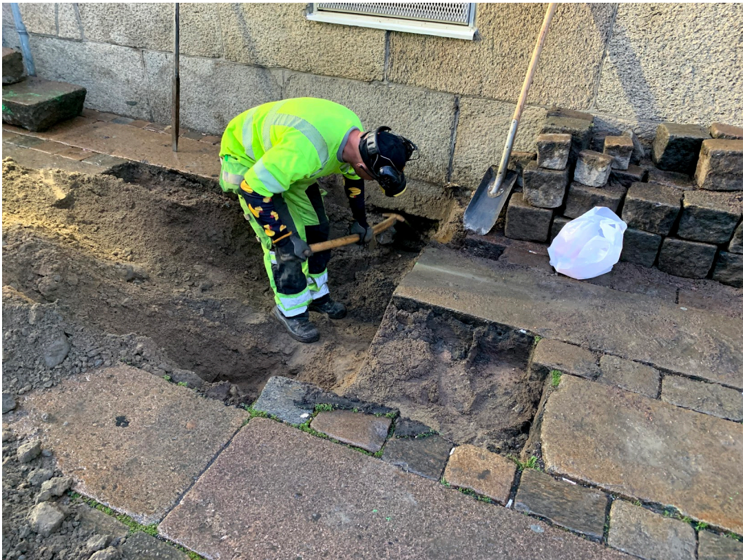
Figur 8. Arbete vid schaktningen i gatan utanför rådhuset. Foto mot nordväst.
