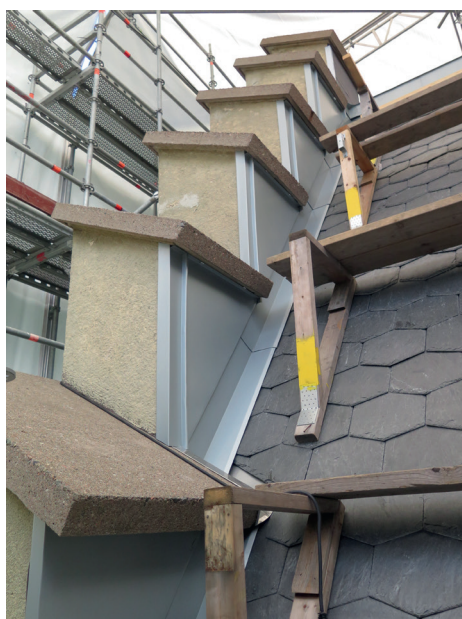
Bilden visar gavelkrönets trappgavel som täkts med rostfri plåt.
