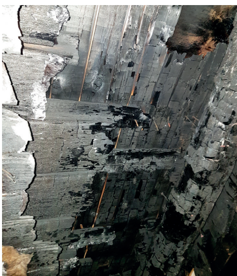
Taket efter branden. Här ser man original takets uppbyggnad med råspånt och in- nertakets panel. Där efter syns 1970-talets tilläggsisolering med isolermatta och glespa- nel.se illustrationen på sidan 19.
