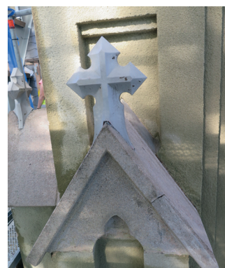
Bilden visar gavelkrönets trappgavel före plåttäckningen
