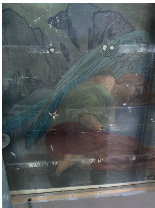
När skivor och läkt tagits bort syns omfattande skador.
