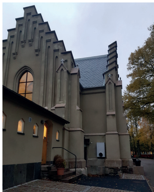
Ett ventilationsdon har monterats på väggen.
