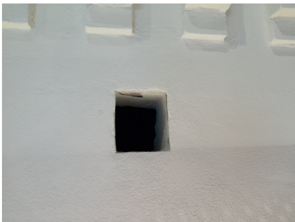
Väggarna är murade med ventilationshål förbundna med kanaler. Bilden ovan visar ventilationshål vid takfrisen och bilden till höger är en närbild på samma hål.
