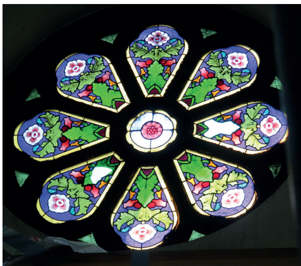
Rosettfönstret före renoveringen. Fönstret var sotigt och flera glas var spruckna, andra hade provisoriskt bytts ut under årens lopp.
