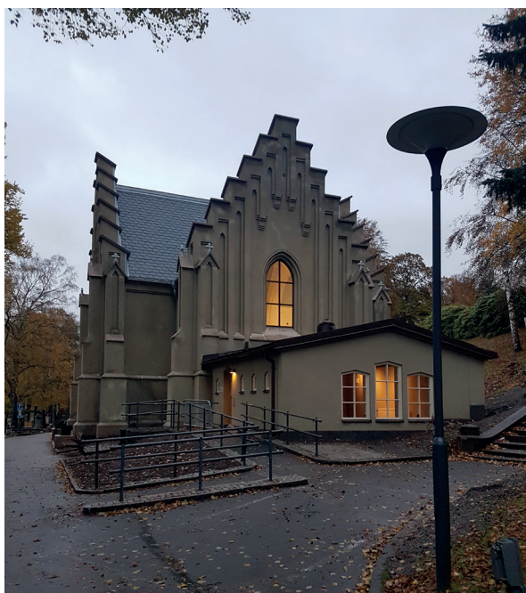
Tillgängligheten har förbättrats med ramp och dörrautomatik in till kapellets entrérum.
