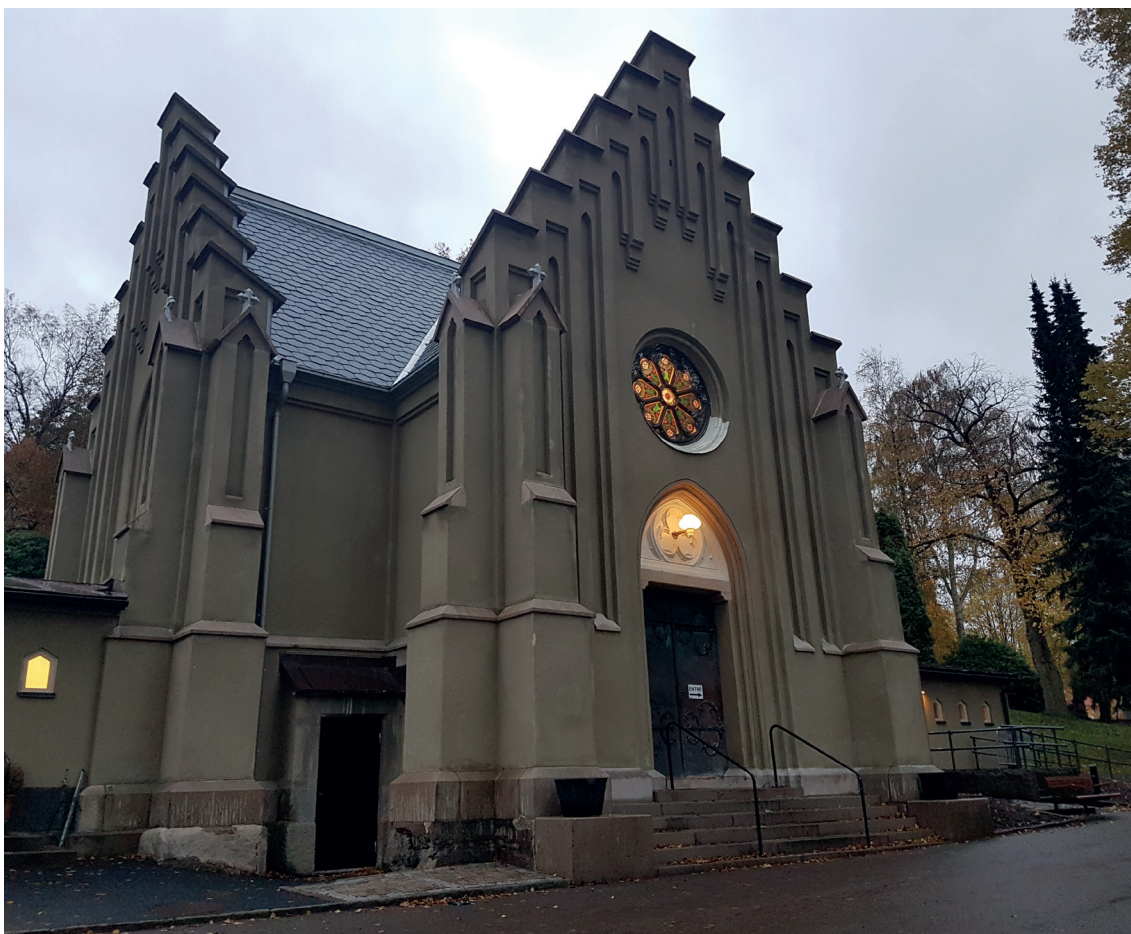
Kapellet står klart efter renoveringen med skiffer som taktäckning. Notera källardörren som bytts ut
