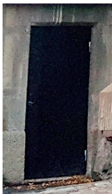
En ny plåtdörr med brytskydd har nu ersatt den gamla dörren.
