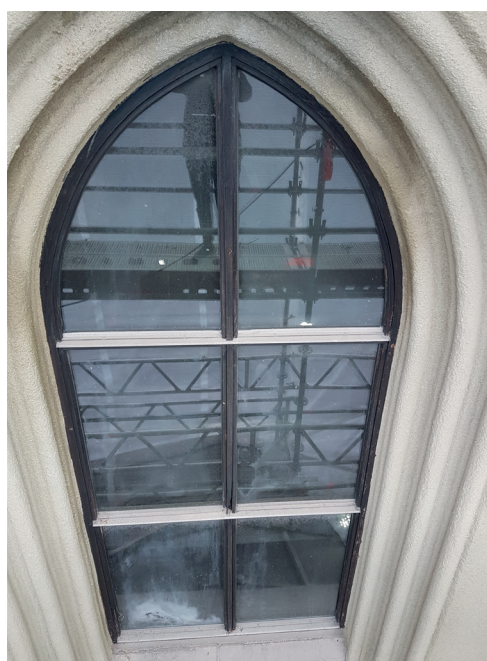
Kapellets övriga fönster är mycket enkla.. Glasen byttes till 2-glas, 4mm float grå (rökfärgat) / 6mm / 3mm ofärgat maskinantik
