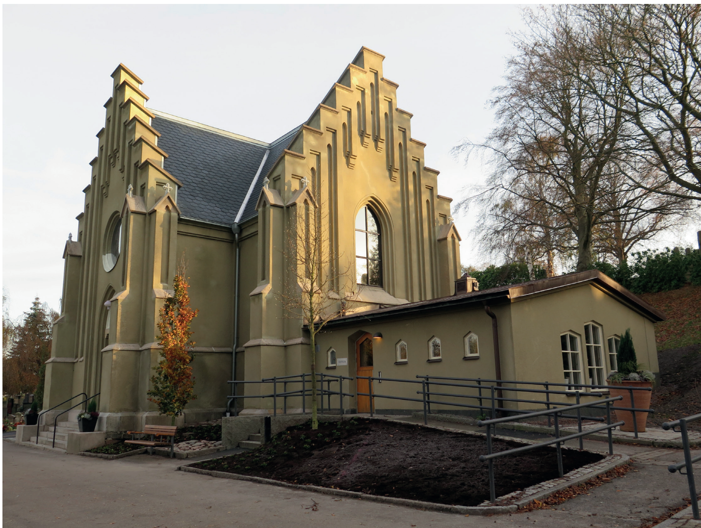
Östra kapellet efter renoveringen
