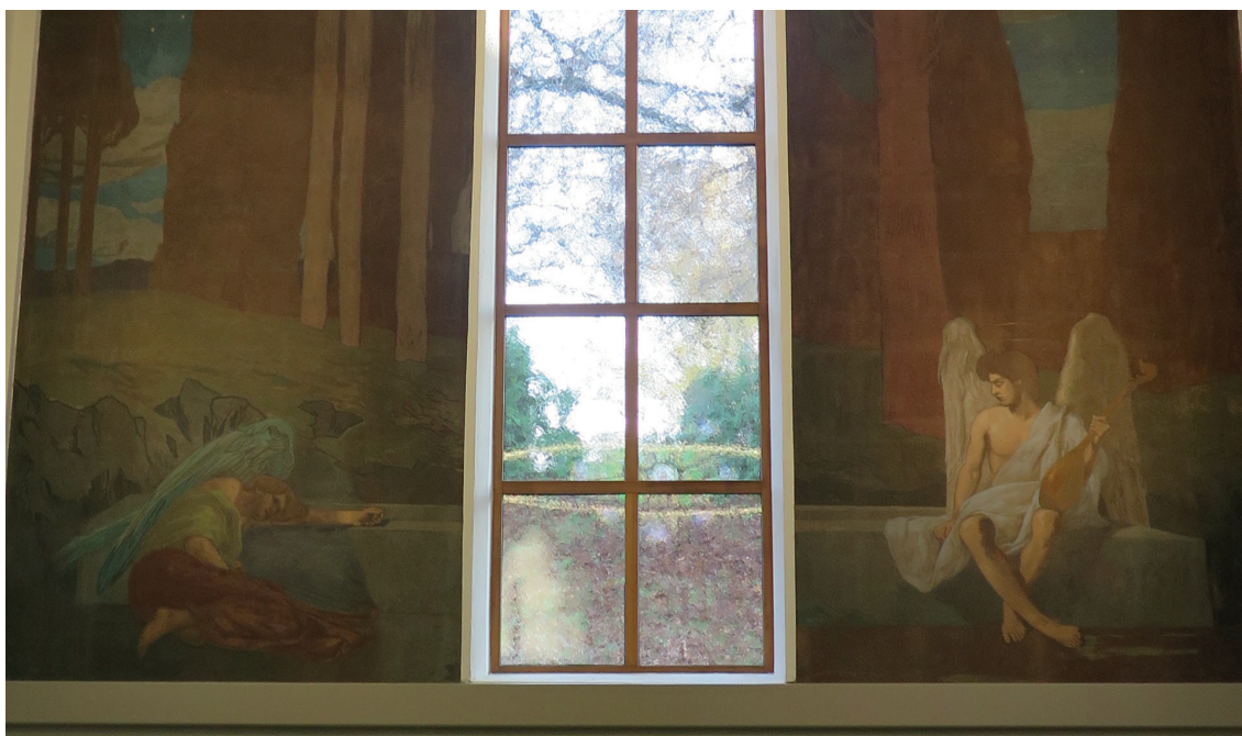
Den färdig behandlade väggen med målningar i öster.
