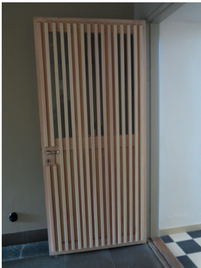
Dörren mot väntsalen med dekorlister av furu, som vitpigmenterats och klarlackats. Bilden till vänster visar dörrbladet mot kapellsalen och bilden till höger visar samma dörr mot väntrummet.
