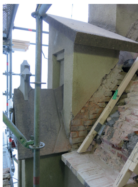
Bilden visar gavelkrönets trappgavel före plåttäckningen
