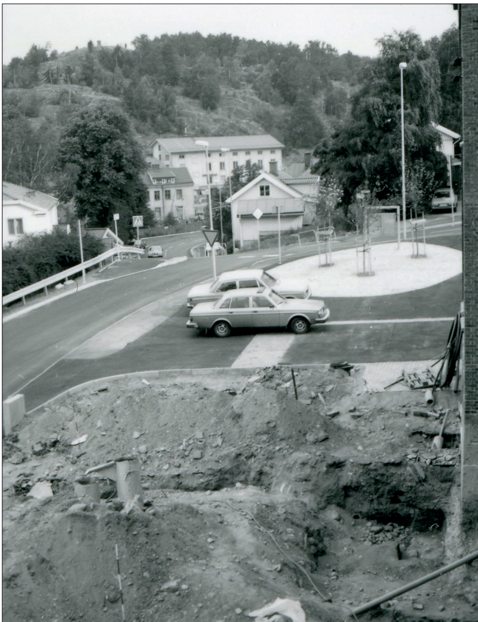
Figur 4. Översikt över utgrävningsområdet från S. I bakgrunden dalgången med Mölndals kvarnby. I höger bildkant västra fasaden av Mölndals museum (f.d. Mölndals sjuksuga).
