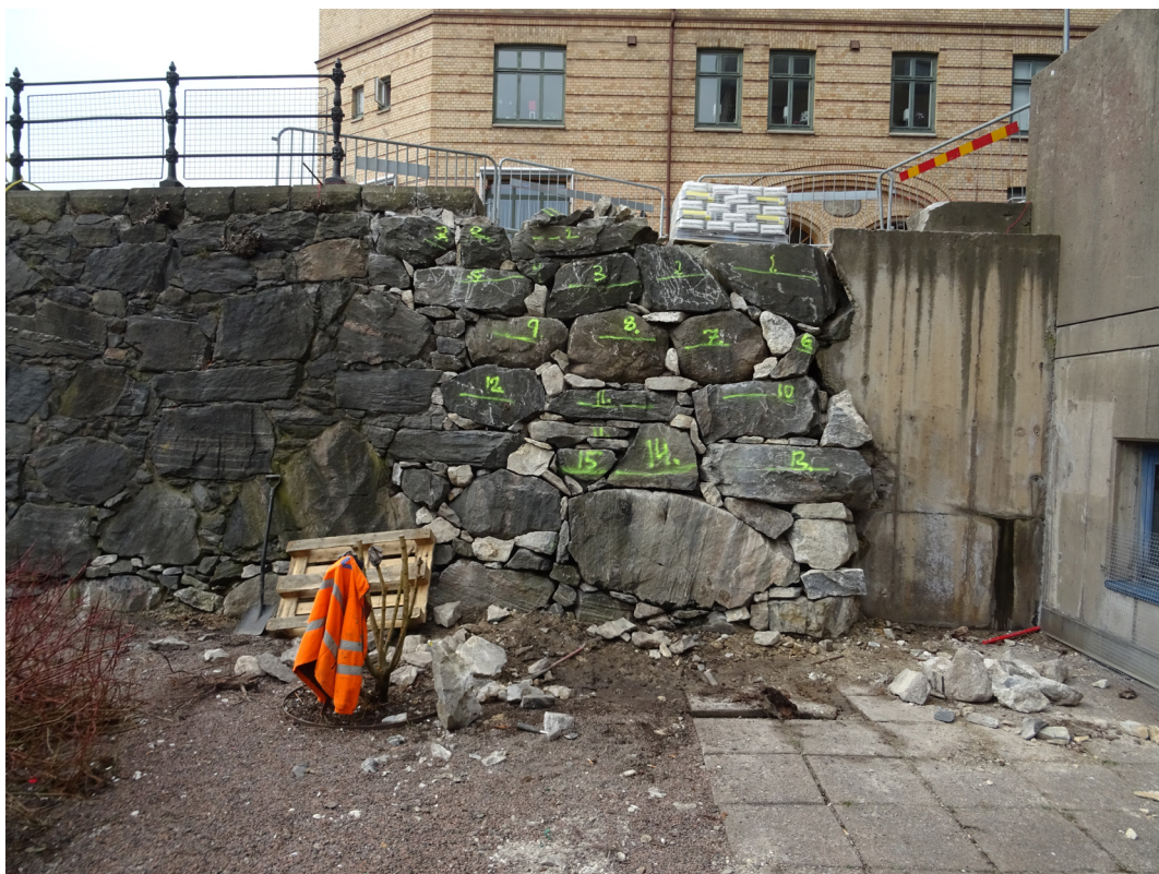
Figur 6 Den östra murdelen vid Christina Regina efter stenblock återmonterats. Blocken är återmonterade på ursprunglig plats.
