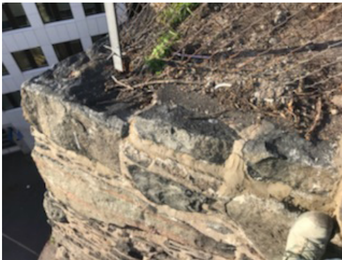
Figur 9. Den östra fasen av Bastion Gustaf Adolf vid färdig renovering. Muren är fogad med gulinfärgat kalkbruk. Foto: Ulf Lundgren, AF Konsult.
