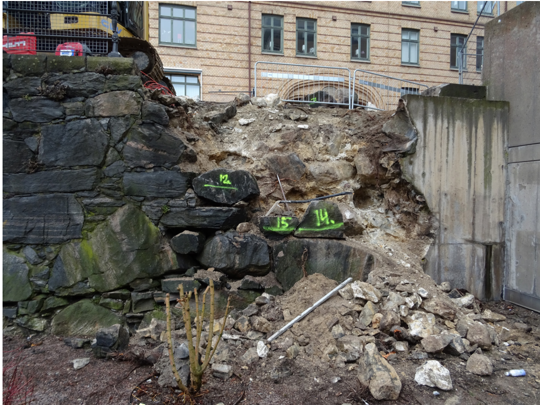
Figur 5. Den östra murdelen vid Christina Regina efter lösa stenar avlägsnats. Här syns den ursprungliga murkärnan av kalkbruk tydligt.
