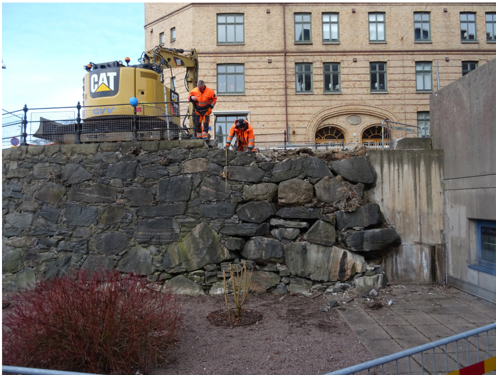
Figur 4. Den östra murdelen vid Christina Regina före demontering och renovering.
