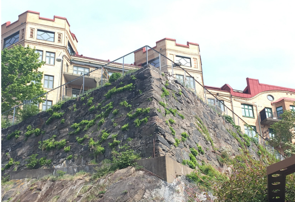
Figur 8. Bastion Gustaf Adolf från utsidan vid färdig renovering. Renoveringen anses vid krönet strax höger om bastionsspetsen där det gula kalkbruket syns.
