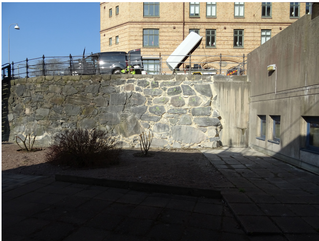
Figur 7. Den östra murens mur vid Christina Regina vid färdig renovering. Muren är fogad med gulinfärgat kalkbruk.
