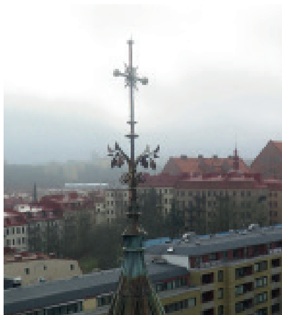
Korkupolen med sitt kors. Före åtgärderna.
