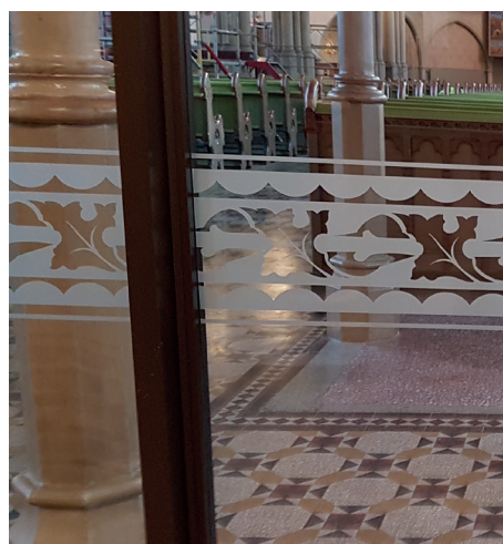
Nya markeringar på befintlig glasvägg har satts upp i form av självhäftande film, till samlingsrummet under västra läktaren.
