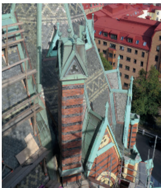
Skorstenen är återuppförd.
