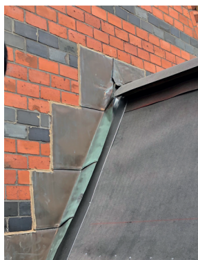
Vinkelrännor och fotbeslag av kopparplåt lades..
