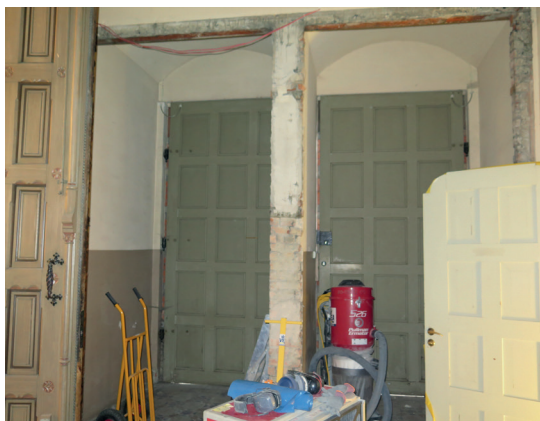
Väggen mellan vindfången har rivits. Insidan av ytterdörrarna syns på bilden.
