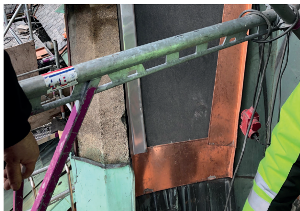
Vinkelrännor och fotbeslag av kopparplåt lades..
