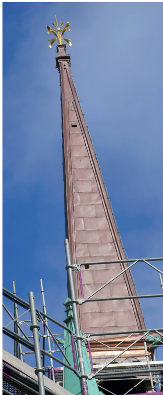
Centrumtornets spira med sin förgyllda korsblomma, efter åtgärderna.
