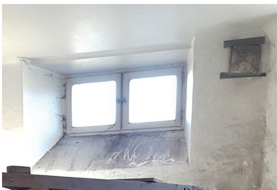
Källarfönstret som restaurerats
