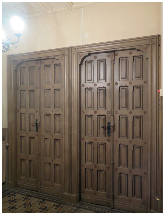
Trapphuset före ombyggnaden. Dörrarna leder till vindfånget.
