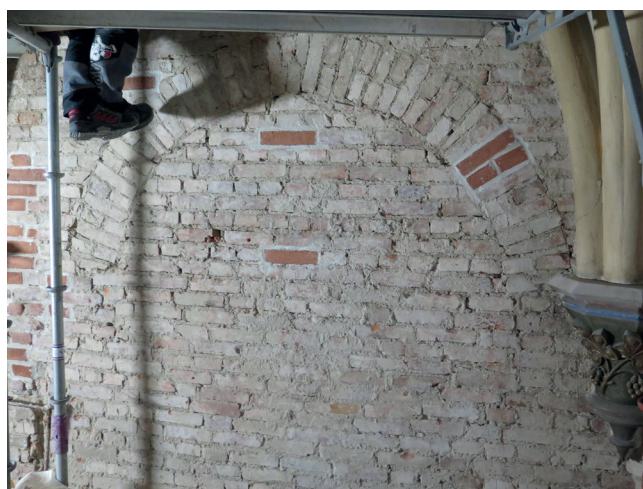
Insidan av kyrkans yttervägg när putsen tagits ner.
