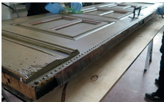
De gamla tätningslisterna byts ut.
