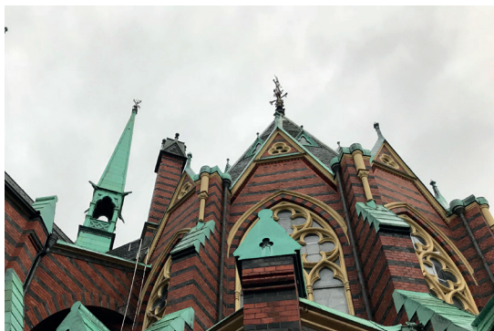
Här syns skorstenen före nedplockningen..
