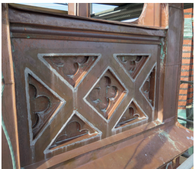
Del av centrumtornet med ny kopparplåt.
