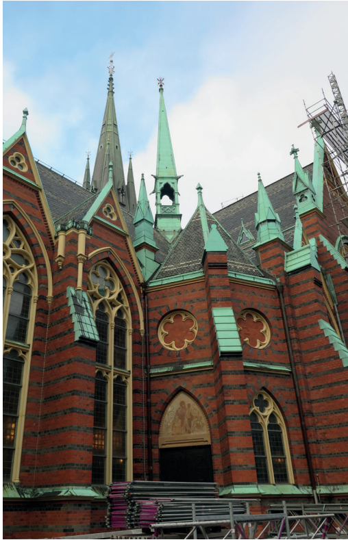
Kyrkans södra takfall före åtgärderna
