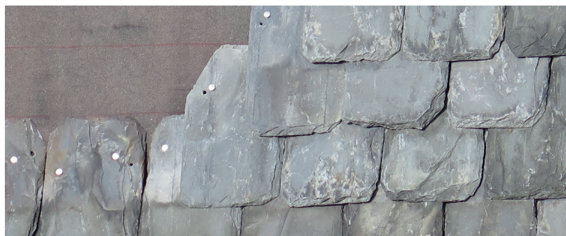
Varje skifferplatta är fästade med två stycken spikar.
