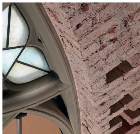
Putsen togs ned på stora delar av kyrkorummets murade väggar över bröstning och på sina ställen har också murteglet kompletterats.
