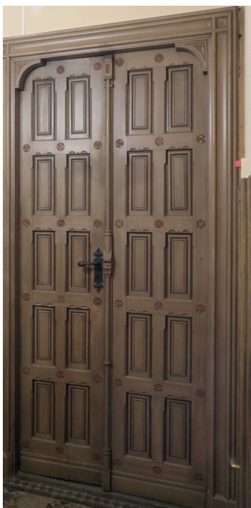
Ombyggd dörr till trapphuset med toaletterna.
