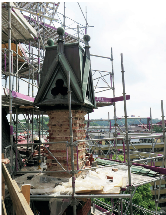
Förbländerteglet demonterades.
