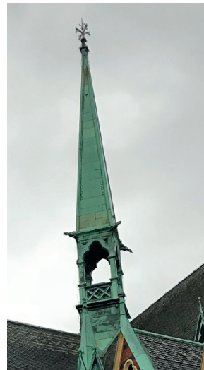
Centrumtornet före åtgärderna..
