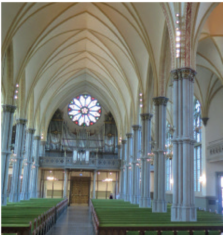
För att kunna belysa takvalven har armaturer med färgat jus monterats på pelarna i långhuset.
