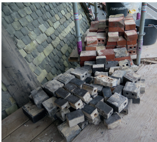
Det demonterade teglet sparades för att återanvändas..
