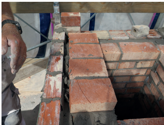
Skorstenen återuppmuras med det ursprungliga förbländerteglet och med ny bakmur..
