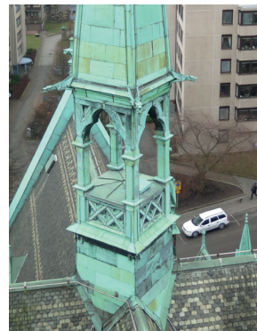
Centrumtornet före åtgärderna..
