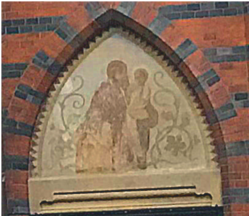
Målningen över kyrkans södra ingång före konserveringen
