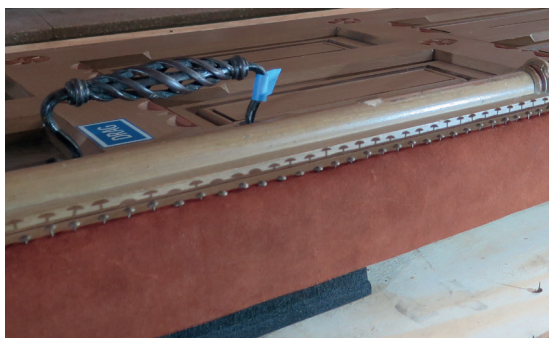
Nya tätningslister är på plats.
