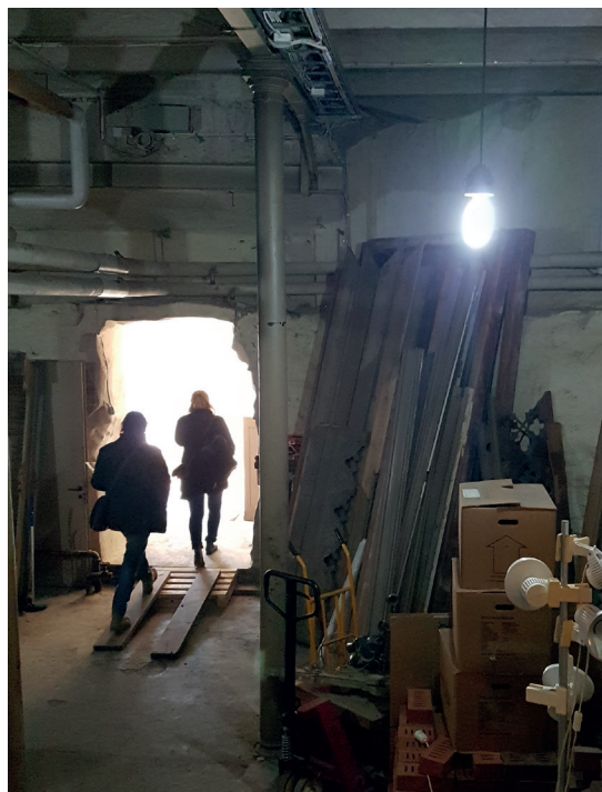
Källarrummet som rengjorts.
