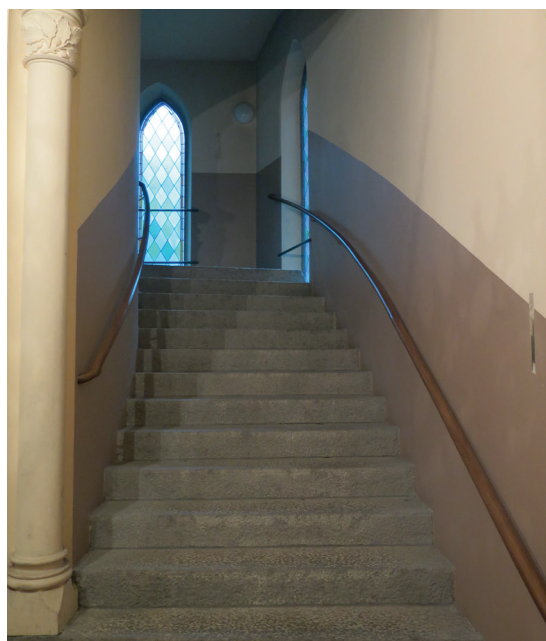
Trapploppet upp till läktaren.
