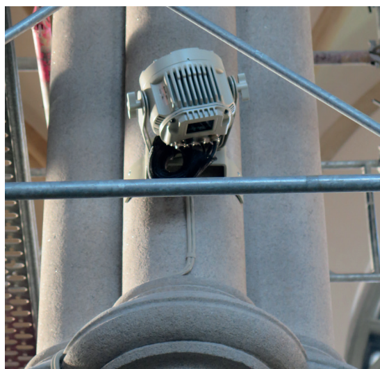
Här syns armaturen för färgat ljus, placerad över svulsten på långhusets pelare.
