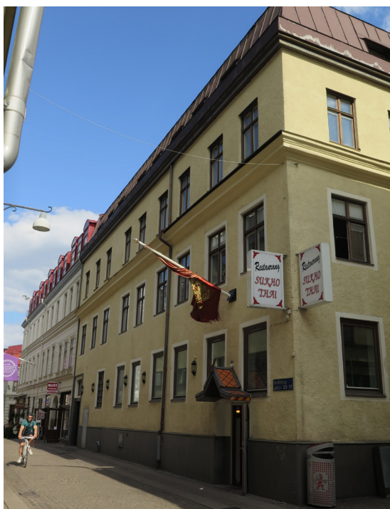
Drottninggatan 17-19 från 1803-1806 höjdes under sent 1800-tal ovan den ursprungliga taklisten.
