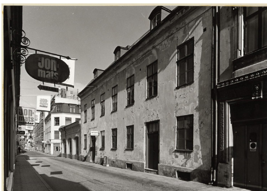
Magasinsgatan åt söder, hus från 1810, rivet på 1970-talet.
