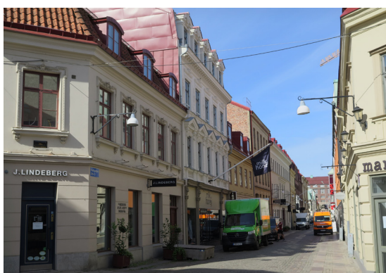
På Korsgatan 17 (till vänster) revs 2003 en våning påbyggd 1938 och fasadernas nyrenässansprägel stärktes.
