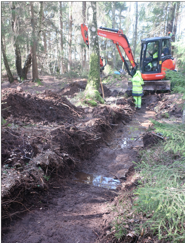
Figur 4. Schakt grävdes med en mindre gräv-maskin. Fynd och anläggningar dokumenterades.
