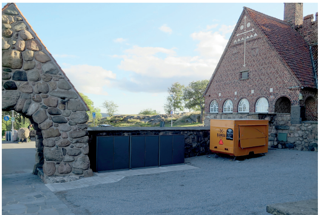
Ytan med kärigaragen och gånen av betongplattor.
