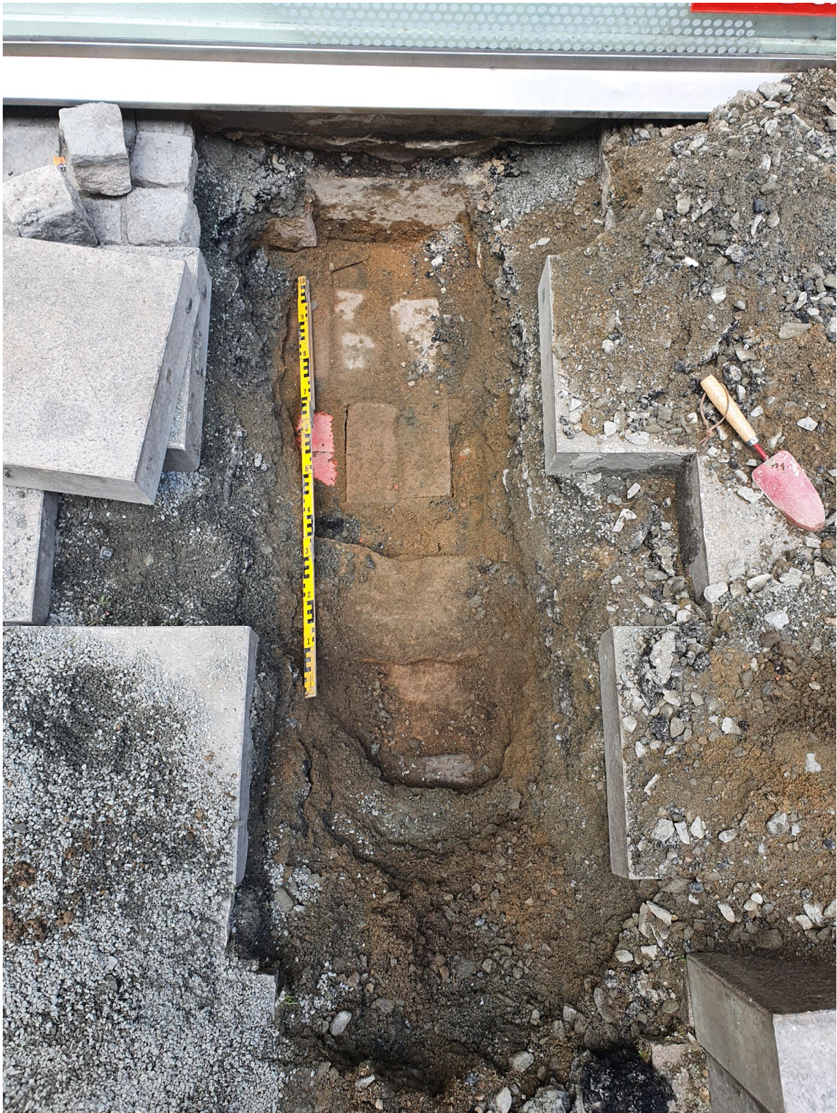
Figur 9. I provgrop 2 påträffades endast fyllnadsgrus, ledningstegel och aktiva ledningar. Foto mot norr.
