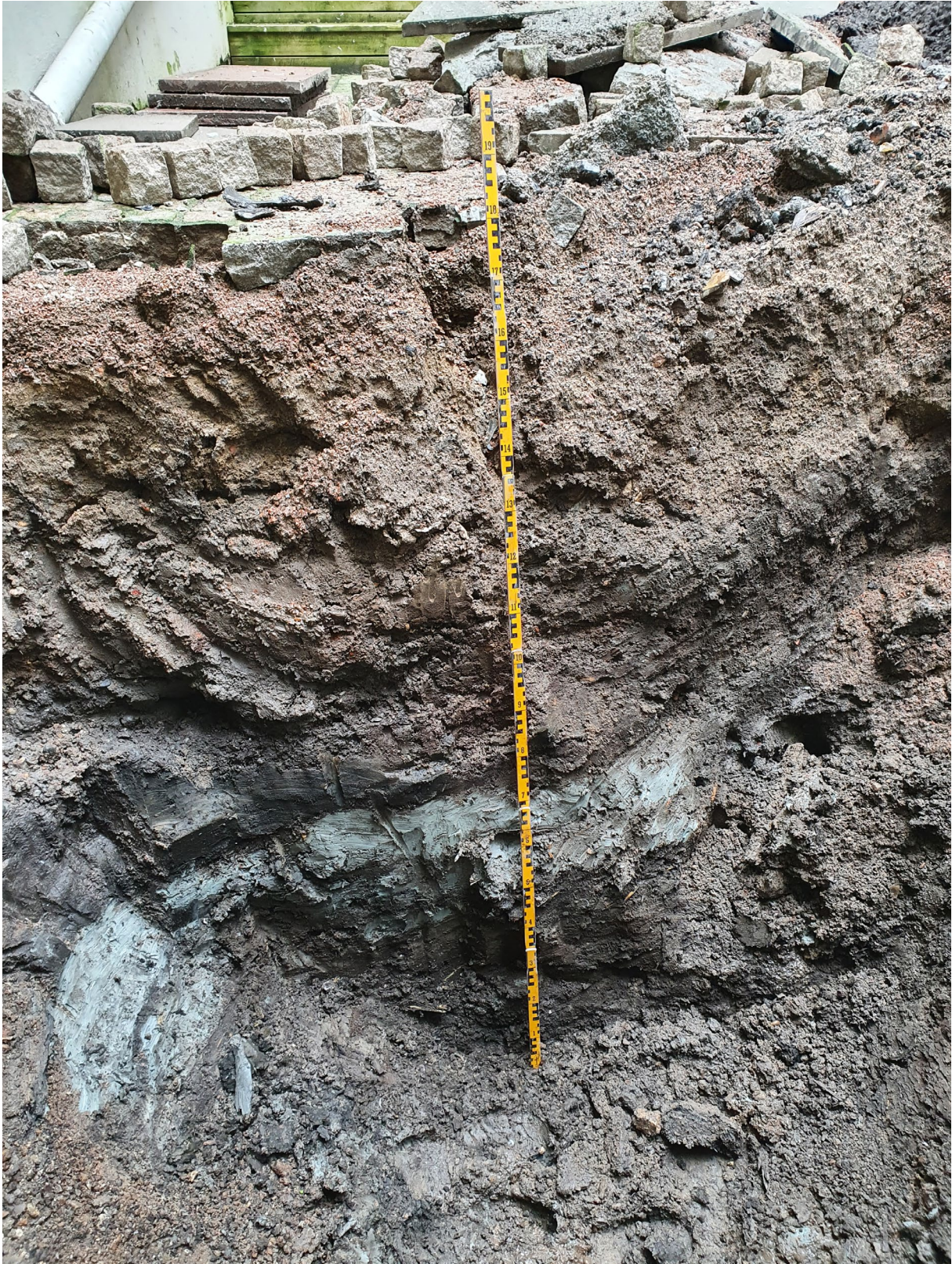
Figur 6. Profilbild provgröp 1. Efter cirka en meter framkom mörka kulturlager varvat med påförd lera om vartannat. Foto mot norr.
