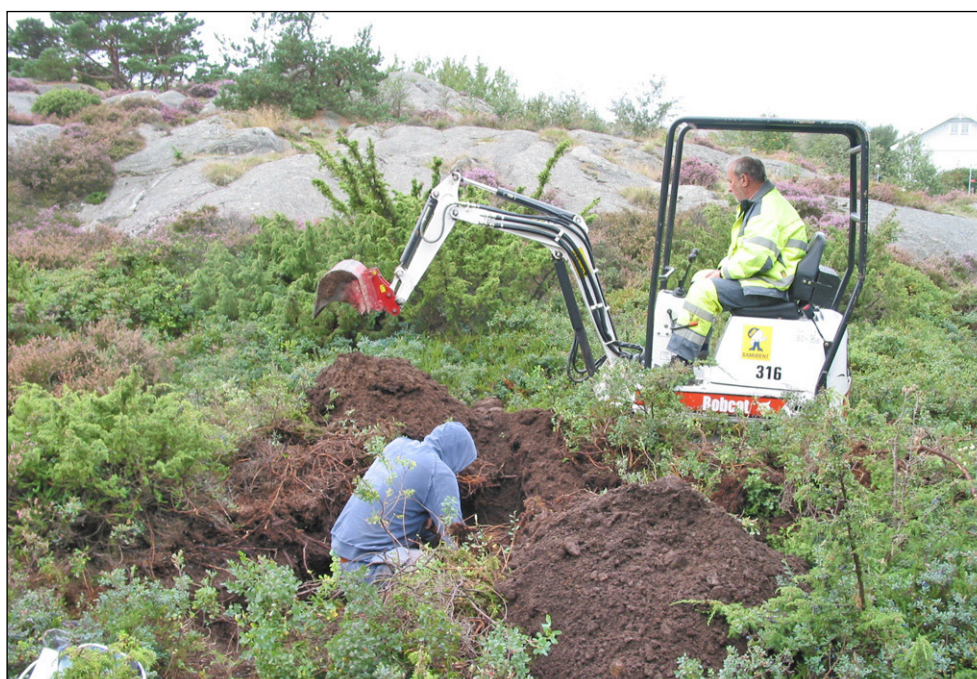
Figur 12. Magnus von der Luft gräven i schakt.
