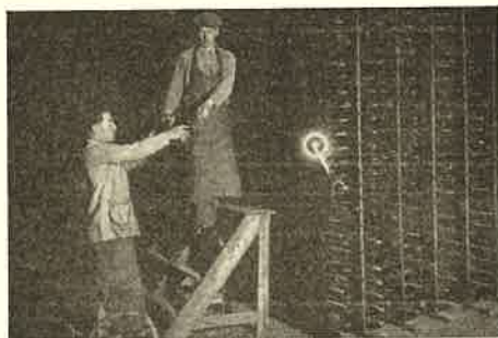
Lagerkällare tillhörande Huset F. Chauvenet
