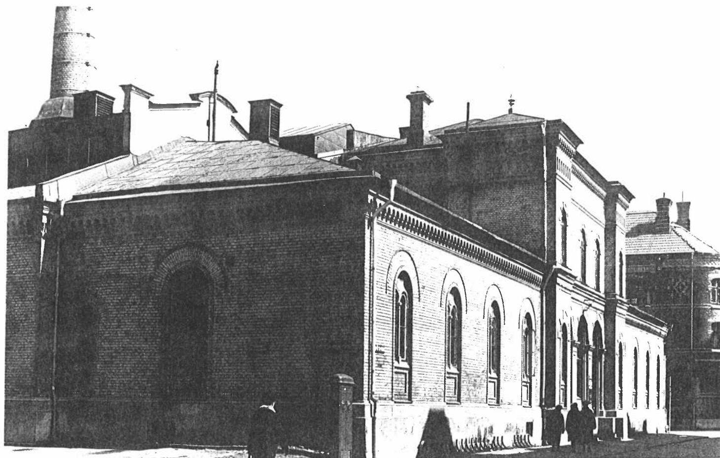
Fasad mot Haga Östergata - Västra Skansgatan. Rester av planterad förgårdsmark längs Västra Skansgatan. Foto 1970.
