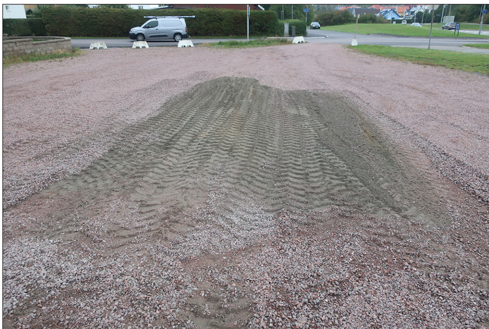
Figur 4. Ett schakt grävdes på den hårdgjorda ytan i nordvästra delen av utredningsområdet. Foto mot väster.
