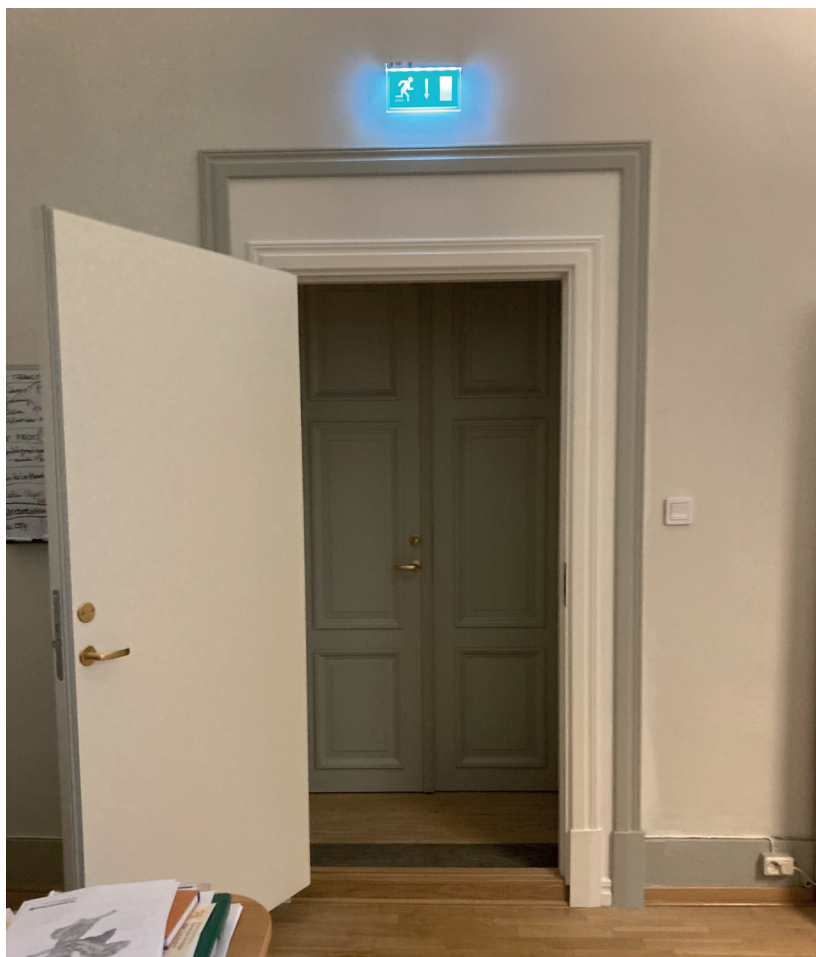
Dörrarna i kontorsrummet efter ombyggnad. Pardörren har flyttats och livar väggen på orgelläktaren, inåt kontorsrummet sitter en ny dörr och trappan ner till orgelläktaren har flyttats ut på läktaren.
