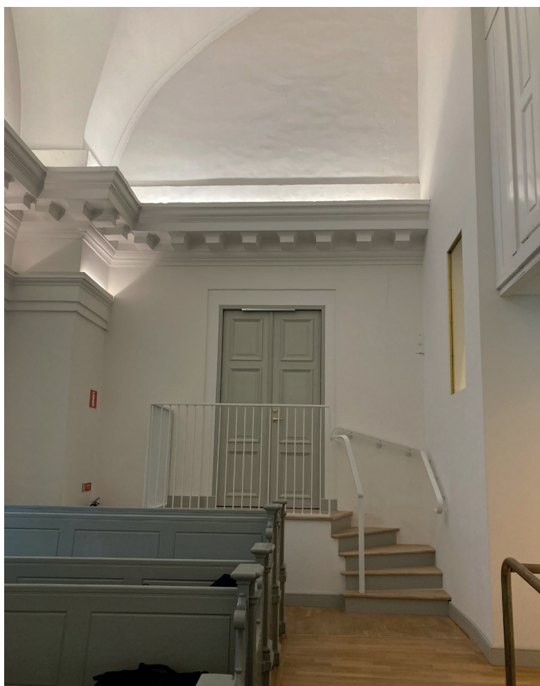
Dörr och trappa vid orgelläktaren före ombyggnad. Pardörren livar kontorsrummets vägg och trappans fem steg ner till läktaren börjar i muröppningen. Handedarna tillkom vid kyrkans ombyggnad 2015.
