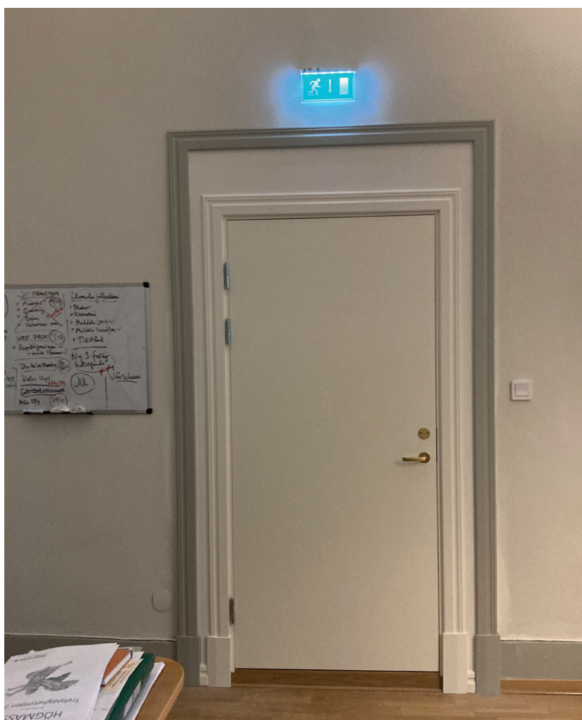
Till kontoret har en enkeldörr monterats i en ny slätvägg för anpassning till den större dörröppningen. Befintligt dörrfoder har behållits runt ursprunglig muröppning. Kulör på vägg, kulör NCS S 0500-N.
