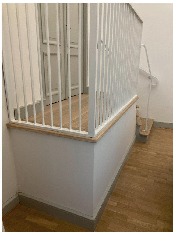
Dörr och trappa vid orgelläktaren efter ombyggnad. Pardörren har flyttats och livar väggen på orgelläktaren. Den ursprungliga trappan finns bevarad under den nya trappan. Det nya räcket har fått en utformning lik avsattsen på södra sidan om orgeln. Kulör på sättsteg NCS S 2502-Y.
