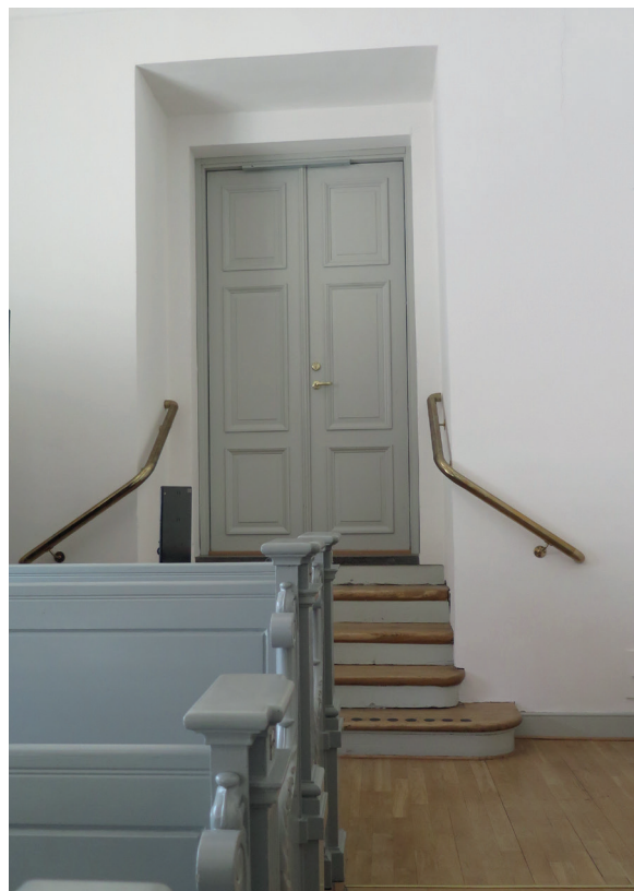
Dörr och trappa vid orgelläktaren före ombyggnad. Pardörren livar kontorsrummets vägg och trappans fem steg ner till läktaren börjar i muröppningen. Handedarna tillkom vid kyrkans ombyggnad 2015.
