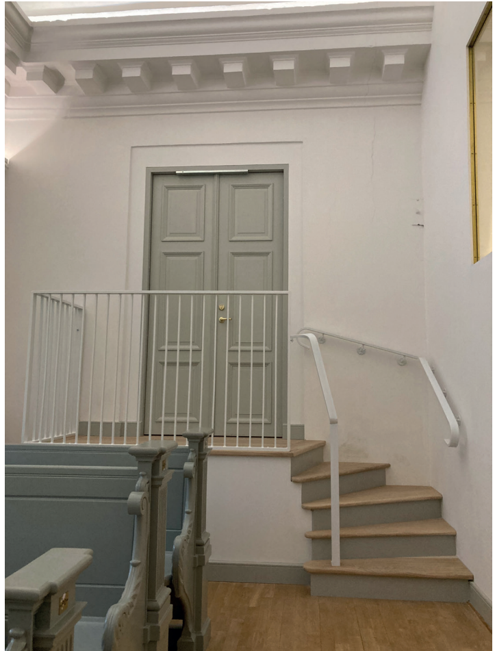
Orgelläktarens norra sida med ljudsluss och nytrappa efter ombyggnaden 2021.
