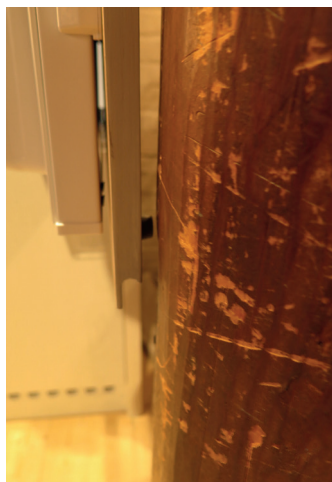
Gummistoppen ger frysдörren en distans till pelarens bas.
