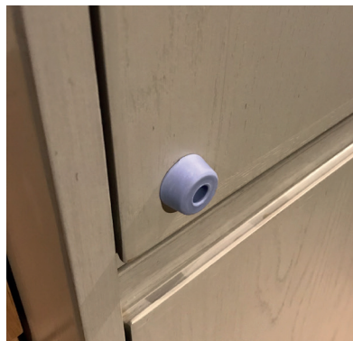
En gummistopp har monterats på dörrarna
