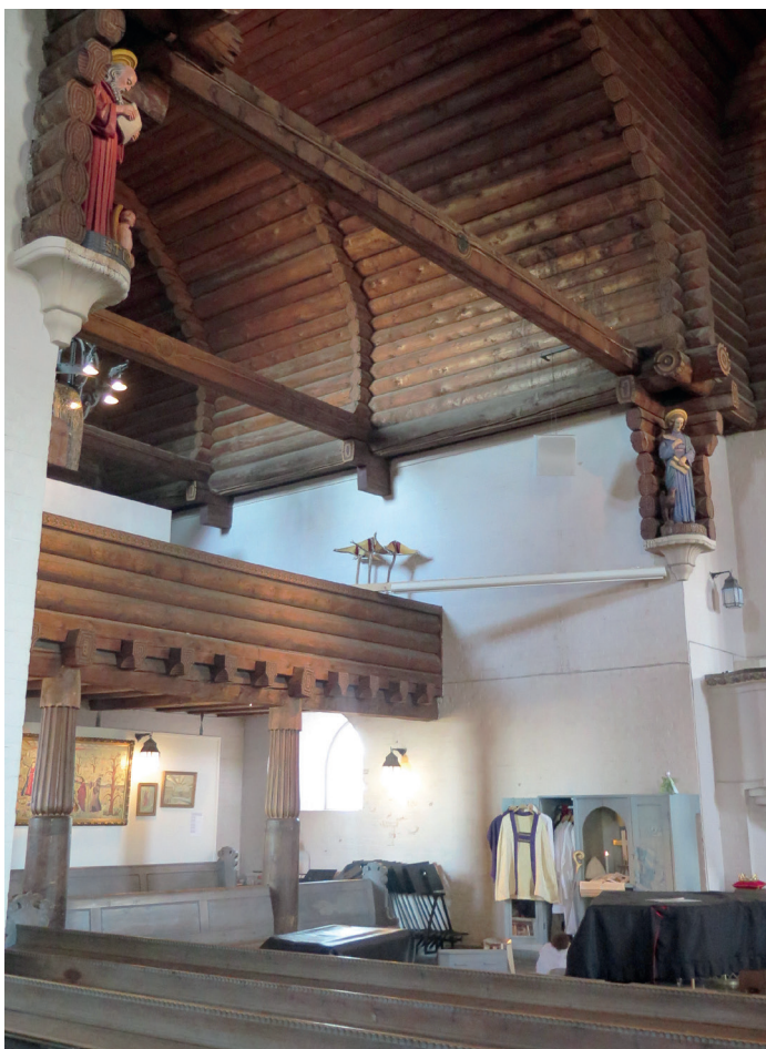
Den norra korsarmen före ombyggnaden.
