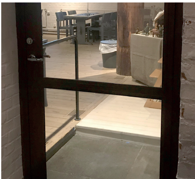
Skissen visar pentryt och den ledstång som stödjer steget mot den bakre dörren. Fotot visar den kortade ledstången och det kompletterade golvet.
