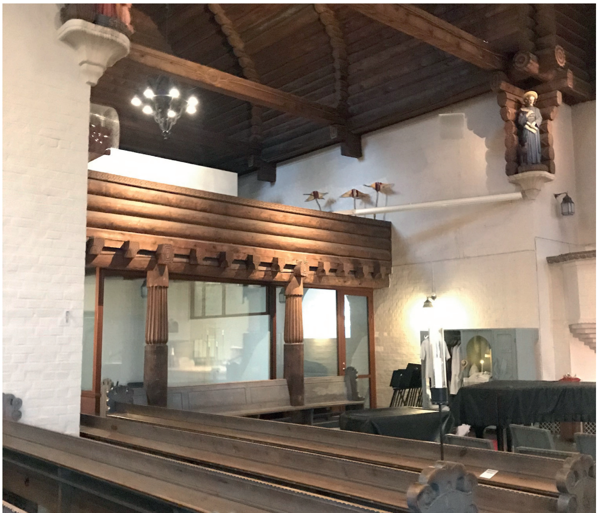
Den norra korsarmen med den nya glasväggen notera också mellanväggen i trä med glasad överdel innanför glasväggen.
