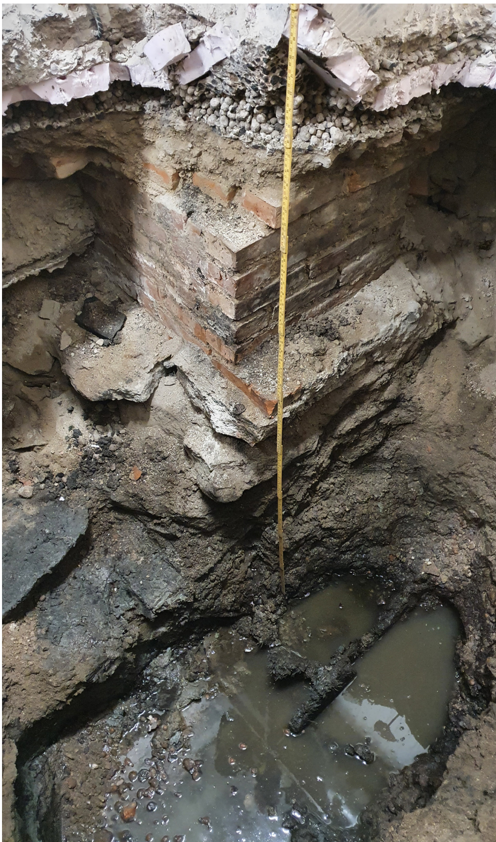
Figur 19. Översiktbild över provgrop 9. Till höger i bild skimtar ovansidan på stående plank i en avfallsbinge. Foto mot norr.
