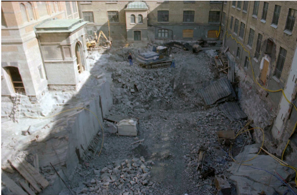
Figur 18. Inngården vid urschaktning av sprängt berg efter att lämningarna avlägsnats, mot öster.
