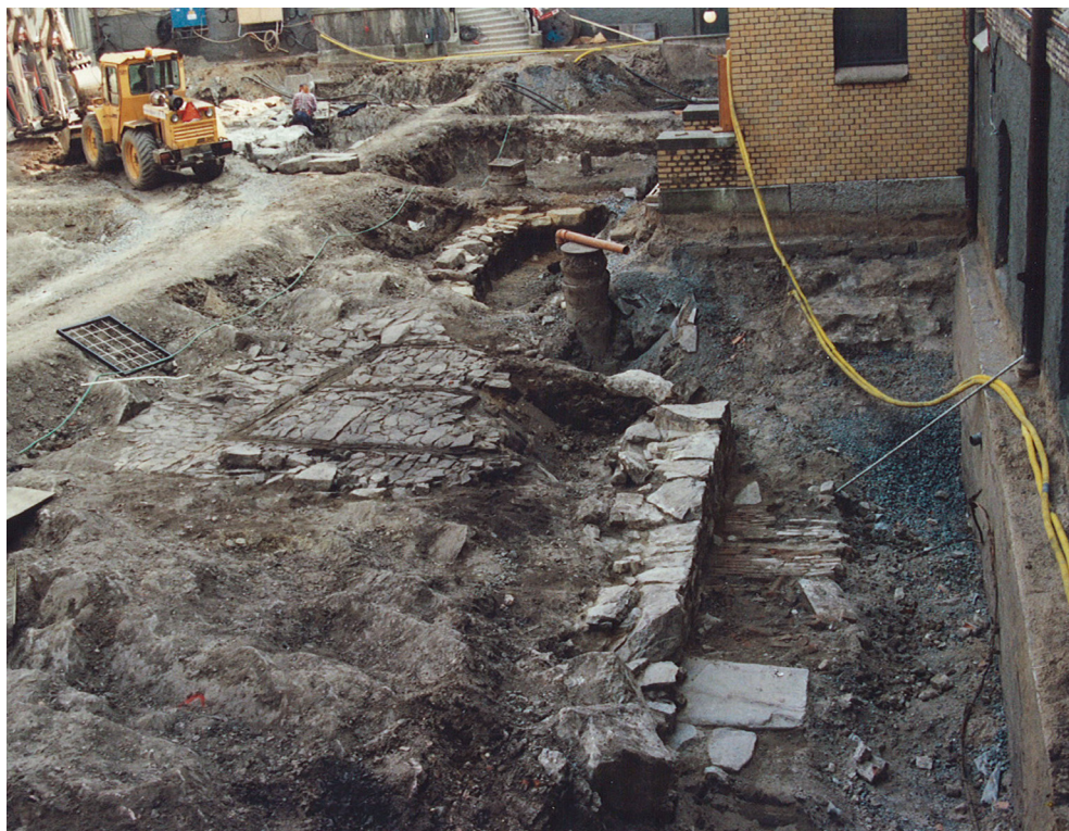
Figur 10. Anläggning 1 med stenläggning 1A, grundmur 1B och golvtegel 1D. I bakgrunden syns grundmur 1C.
