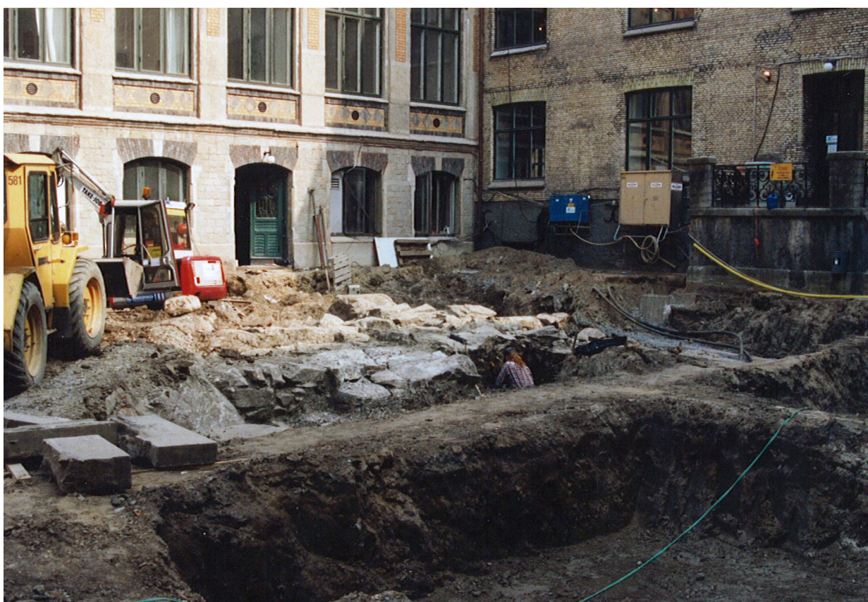
Figur 16. Anläggning 2 vilken bestod av en grundmur till en byggnad på innergårdens nordöstra del.
