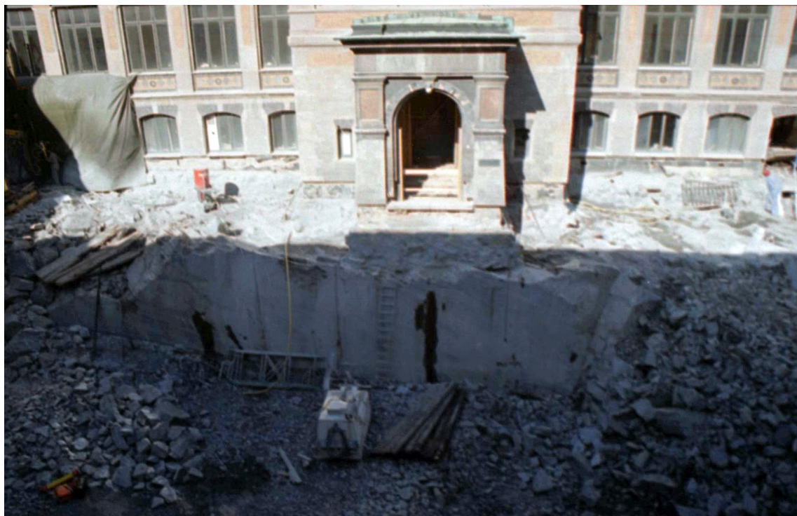
Figur 20. Innergården vid urschaktning av sprängt berg efter att lämningarna avlägsnats, mot norr.
