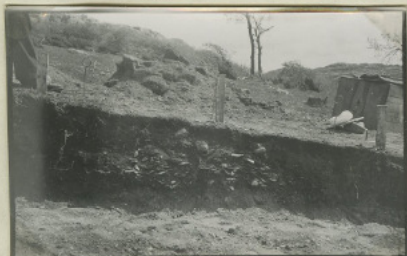
B3786 Plåt n:r a 974. Rörvik. Profil a'-l', ruta e'-f'. Foto S. Janson 28.5.1934.
