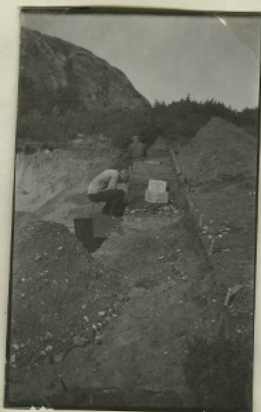
Plat n:r a 978. Rörvik. Bank a 1 -b under arbete. Från SW.
