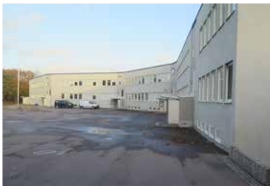
Den S-formade klassrumsbyggnadens norra fasad.
