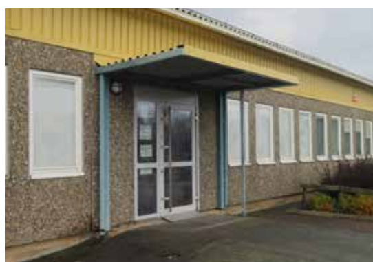
Skärmtak över låg- och mellanstadiebyggnadens entréer.
