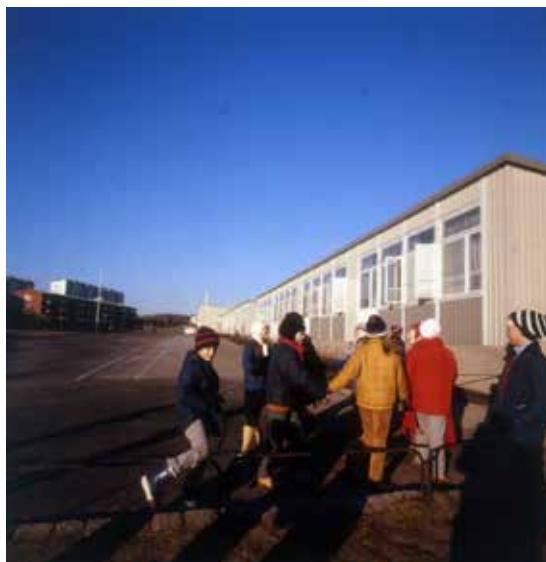
Fågelroskolan i södra Biskopsgården byggdes år 1960 och revs 2005. Foto: Hjärnarkivet, GSM.
