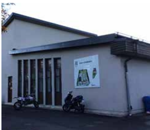
Bambasalen med ljusa putsade fasader.
