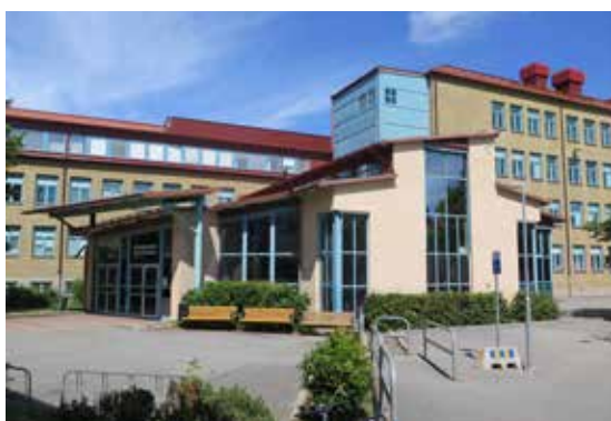
Det tillbyggda entrépartiet för "Lundby stadsdelshus".
