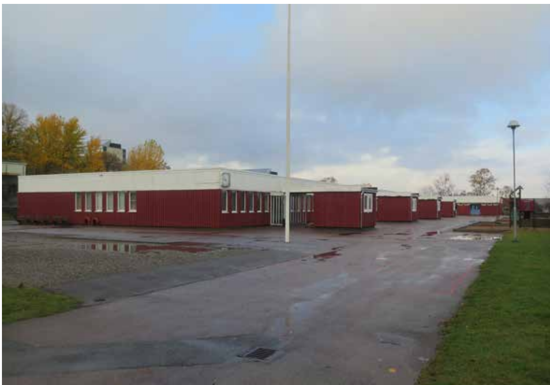
Römossekolans två envåningsbyggnader är mycket välbevarad sedan uppförandet. Skoltypen var vanlig i Angered och på andra platser i Göteborg under sent 1960-tal och tidigt 70-tal, men många av dem har förändrats sedan dess.
