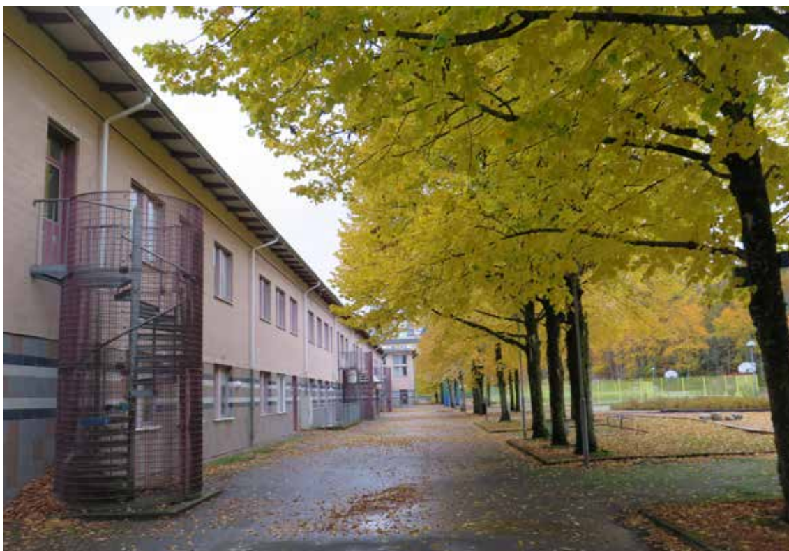
Lövgårdesskolan präglas idag till stora delar av den stora ombyggnad som skedde i början av 1990-talet, då fasaderna fick sin rosabeige färg och bottenvåning klädd i klinker.
