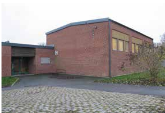
Gymnastiksalen med delvis igensatta fönsterpartier.
