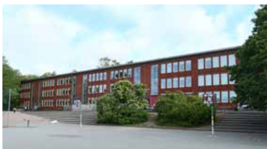
Huvudbyggnadens monumentala fasad mot söder.
