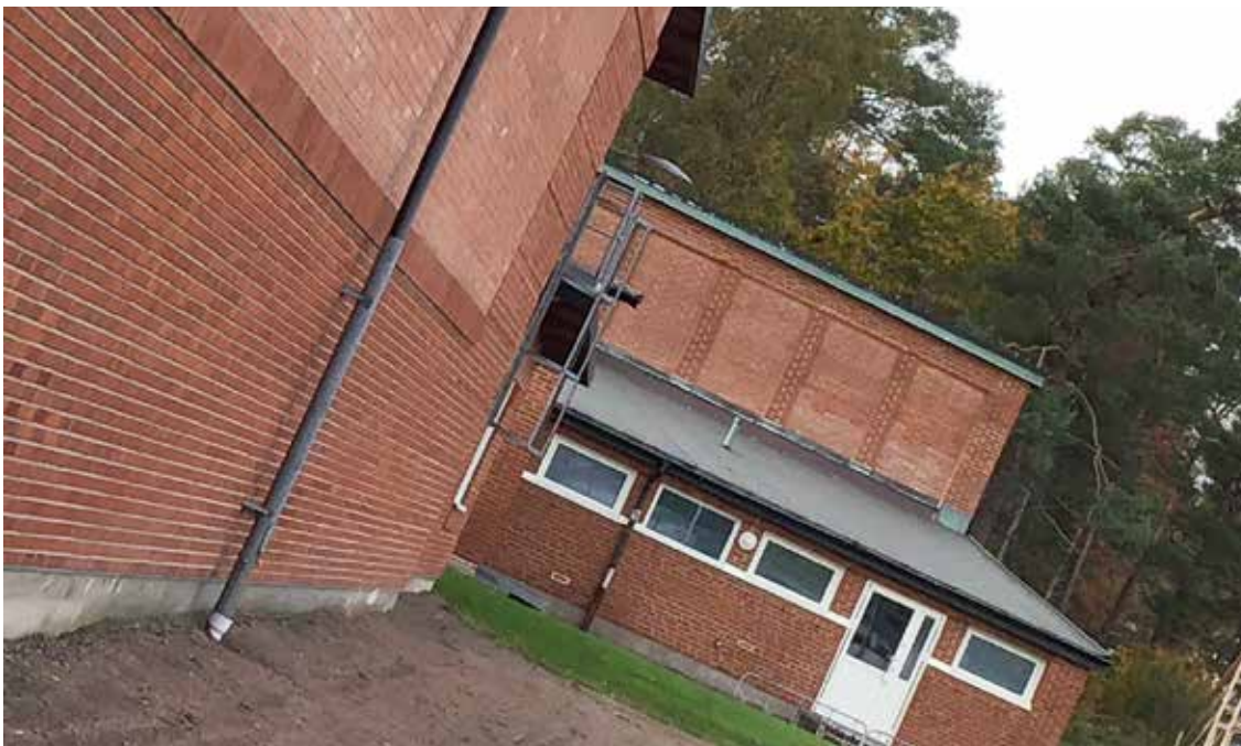
Den äldre idrottshallen, snett bakom den nyare.
