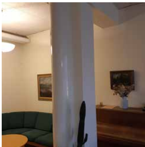
Pelare i personalrummet med tillbyggd ventilations-trumma.
