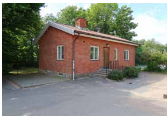
Den fristående före detta vaktmästarbostaden.
