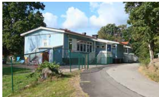
Den ursprungliga paviljongen med sina stora fönsterpartier.
