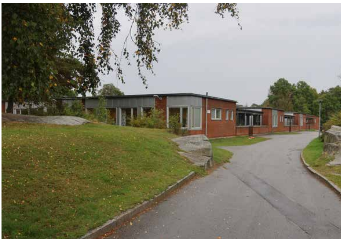
Ångåsskolan är en småskalig anläggning anpassad för låg- och mellanstadiet, placerad på flack mark till skillnad från den samplanerade och -gestaltade Tynneredsskolan. Kamformen skapar mot söder fyra gavelpartier med mellanliggande murar och skärmtak.
