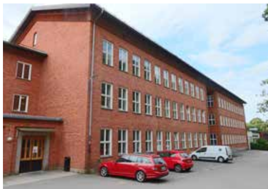
Klassrumsbyggnadens norra fasad.
