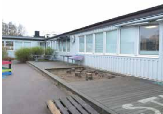
Byggnadernas fasader mot det skyddade gårdsrummet.
