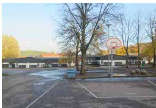
Lågstadiebyggnadens ombyggda fasader mot gården.
