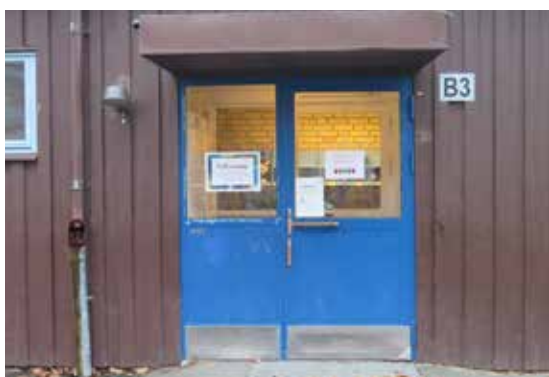
En av lågstadiebyggnadernas ursprungliga portar.
