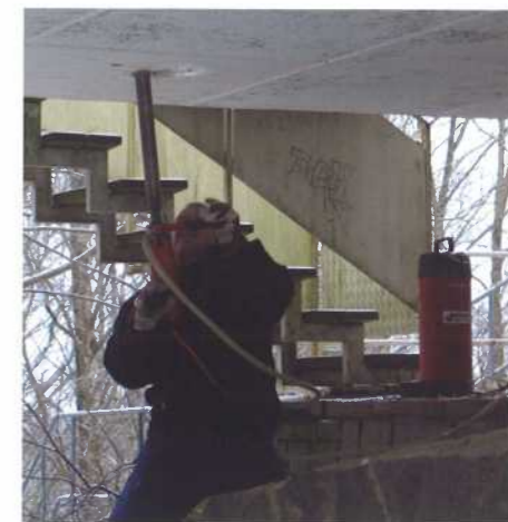
Teknisk undersökning, betongprovtagning 2004.
