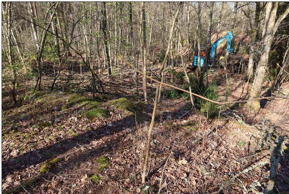
Figur 4. Terrängen i utredningsområdet var inte alltid lättframkomlig för en grävmaskin.
