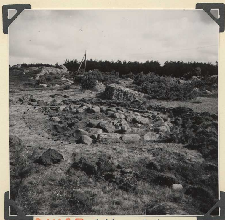
B4625 Efter plåt n:r a 2066.
