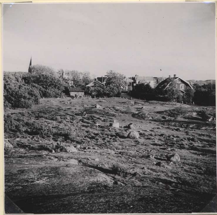
B4670 Efter plåt n:r a 2217. Hög 26 i bildens mitt. s.v. n:r 27 (under arbete) och 34.
