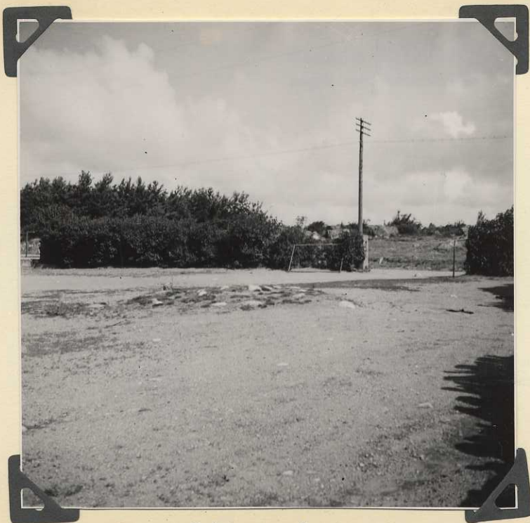
B4609 Efter plåt n:r a 2050. Hög 5. På skolgården. Synlig i bildens mitt. Före undersökn. Från SO. A. Fredsjö foto 11.7.1947.
