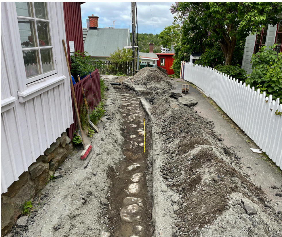
Figur 7. Frilagd stenläggning strax under asfalten på toppen av Slotssberget. Foto mot väst.
