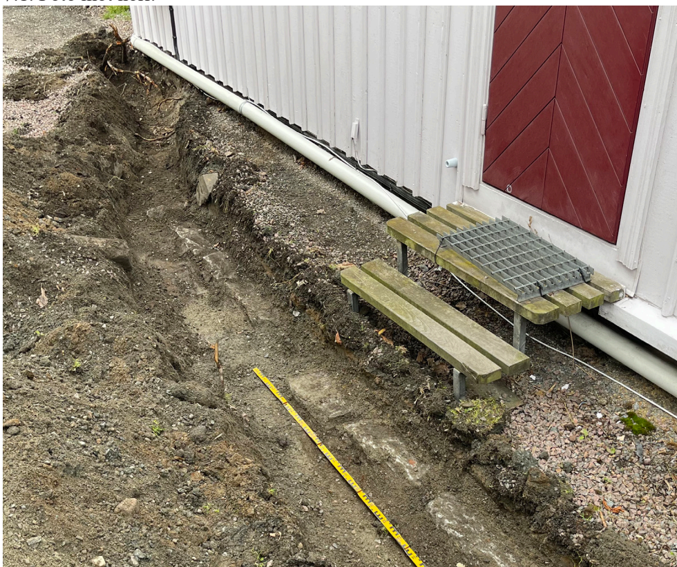
Figur 11. Stenmuren S1K4 mellan fastigheterna Lindholmen 7:16 och 7:12. Foto mot sydväst.
