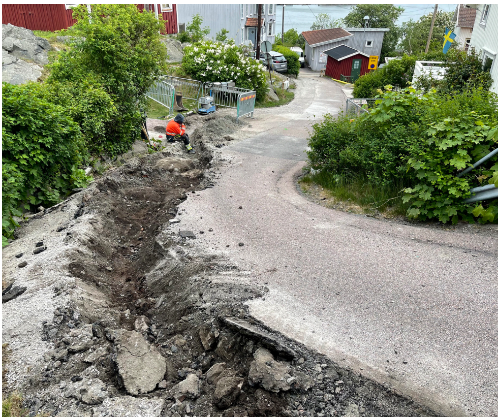
Figur 6. Översiktssbild i södra delen av undersökningsområdet. S1K8 syns här i det bakre stycket av schaktet. Foto mot söder.
