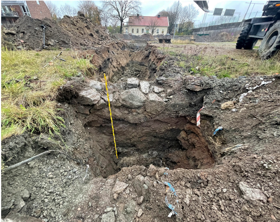
Figur 33. Djupschakt 10 med utsidan av sydvästra grundmuren (S1M3) på utsidan av Länga 2 med mansgårdsbyggnaden i bakgrunden. Foto mot nordost.
