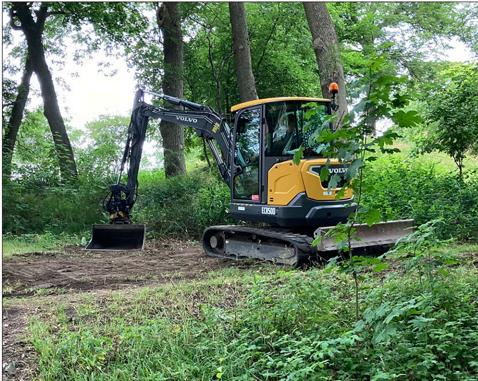
Figur 5. Fältarbetet vid utredningen gjordes med hjälp av en mindre grävmaskin.
