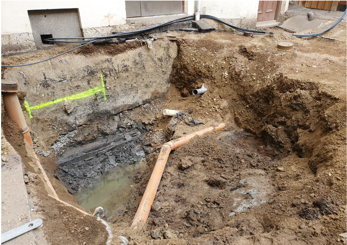
Figur 10. Översikt över undersökningsområdet. Foto mot nordväst.
