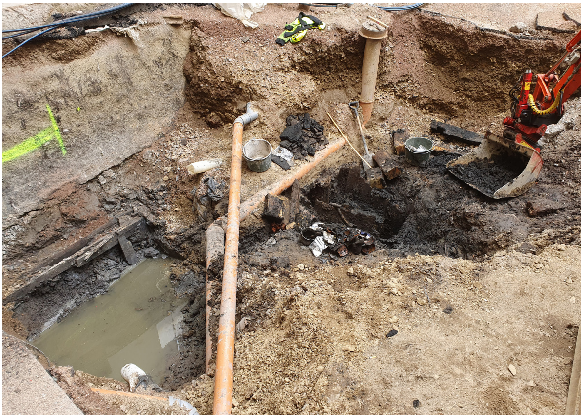
Figur 12. Den östra delen av avfallsbingen har här börjat grävas ut. Den frilagda bingens konstruktion fortsätter under dagvattenröret i västlig riktning. Foto mot nordväst.
