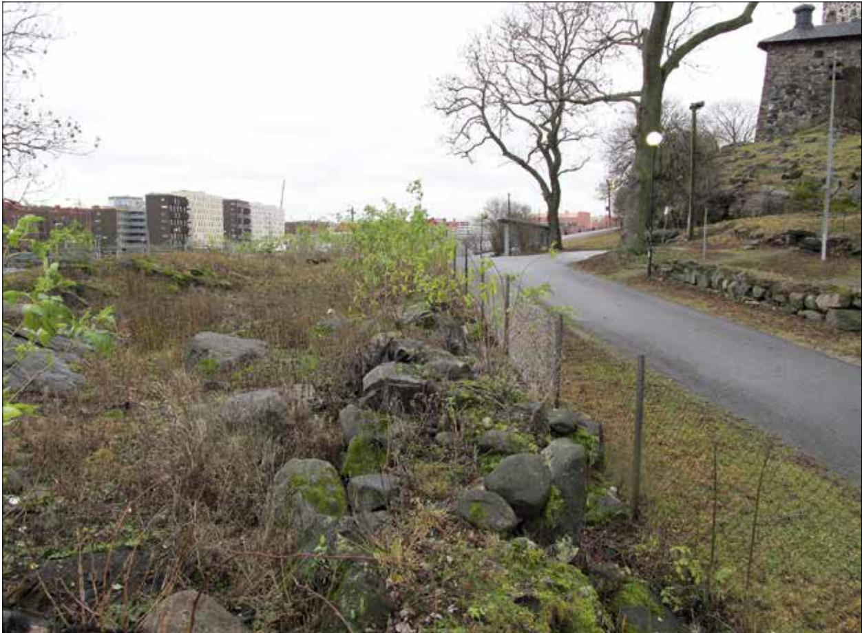
Figur 21. Fotot är taget mot sydväst. På fotot syns delar av vällen med synlig mur på södra sidan av infartsvägen och överensstämmelse troligen med den lämning som dokumenterades av Hans Andersson 1973. På andra sidan vägen, strax nedanför skansen, syns en mur som troligen är tillkommen i senare tid och kan ha tillhört den förvaltarbostad som har funnits på den grusade parkeringsplatsen. Foto: Anders Kjellin.
