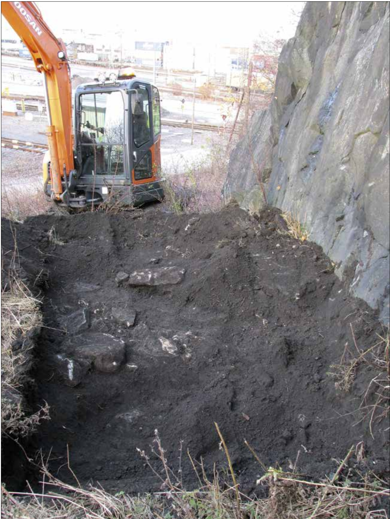
Figur 14. En stenpackning i schakt 5 som tolkas som en murrest. Schaktet förlades på en avsats invid en brant bergvägg. Foto: Anders Kjellin.
