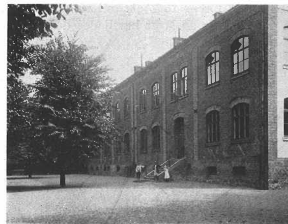
Skolhuset vid Klippan, fasad åt Allmänna Vägen
