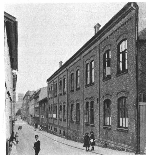
Östra Skansgatan skolhus, fasad åt Kaponnergatan
