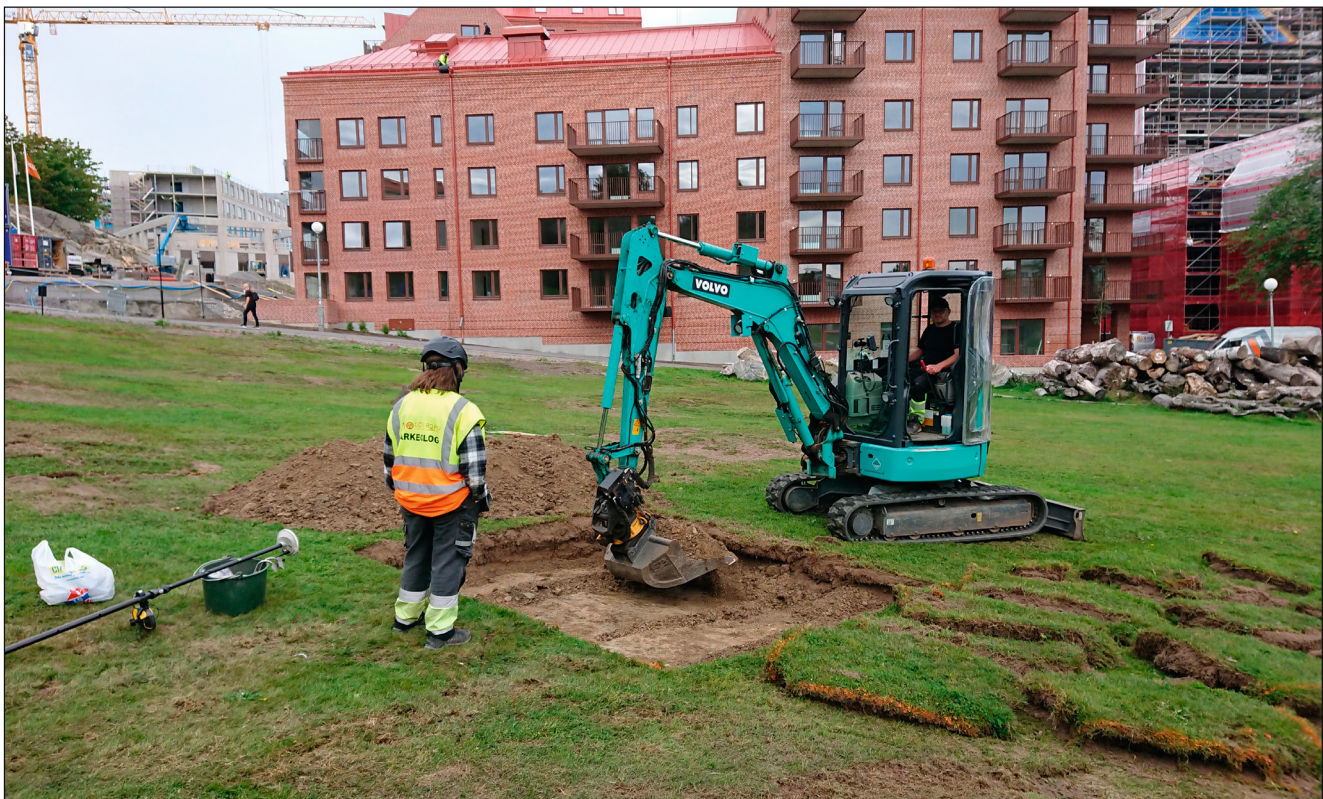
Figur 5. Schakt inom undersökningsområdet. Foto mot nordväst.
