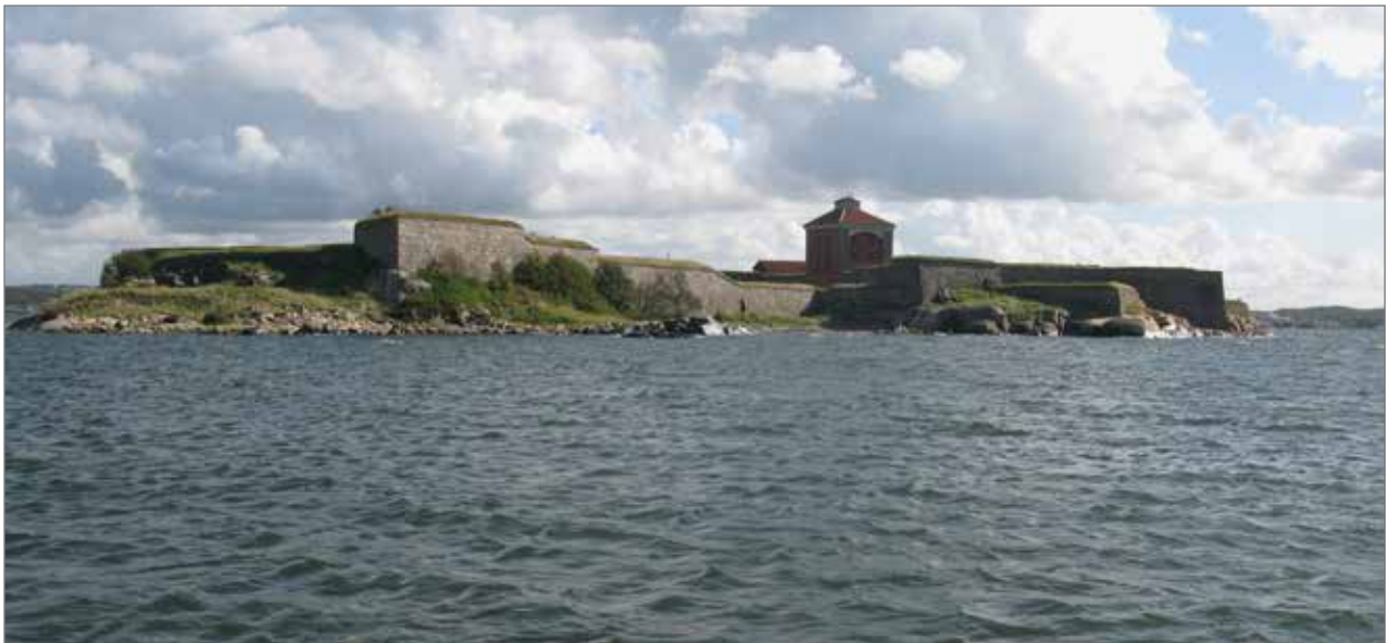
Figur 3. Fästningsholmen från norr. Foto Matthew Gainsford, Bohusläns museum.
