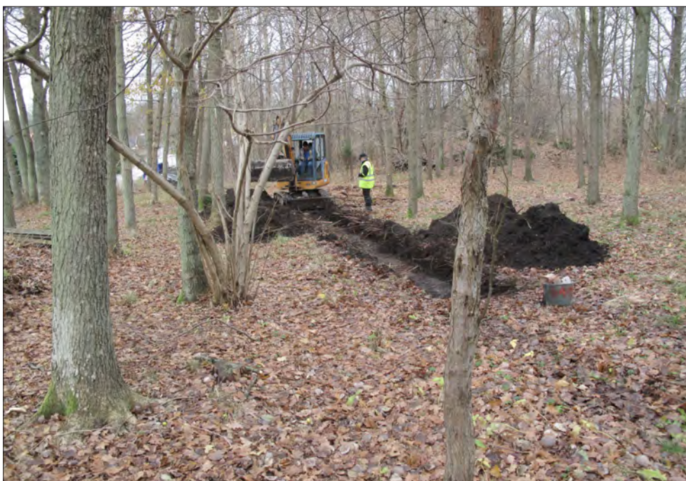
Figur 12. Schakt 9 grävs. Författaren i bild. Foto mot öster.
