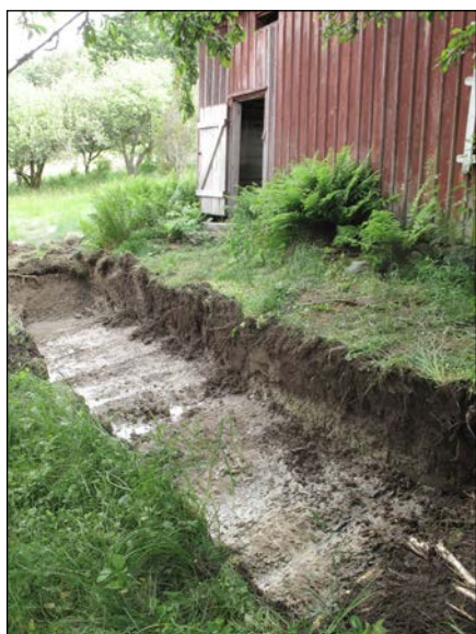
Figur 5. Schakt 1 mot nordost.
