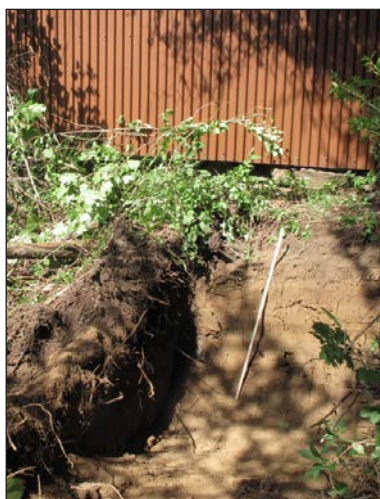
Figur 11 (till vänster), schakt 3 mot SV och 12 (till höger), schakt 4 mot NV.
