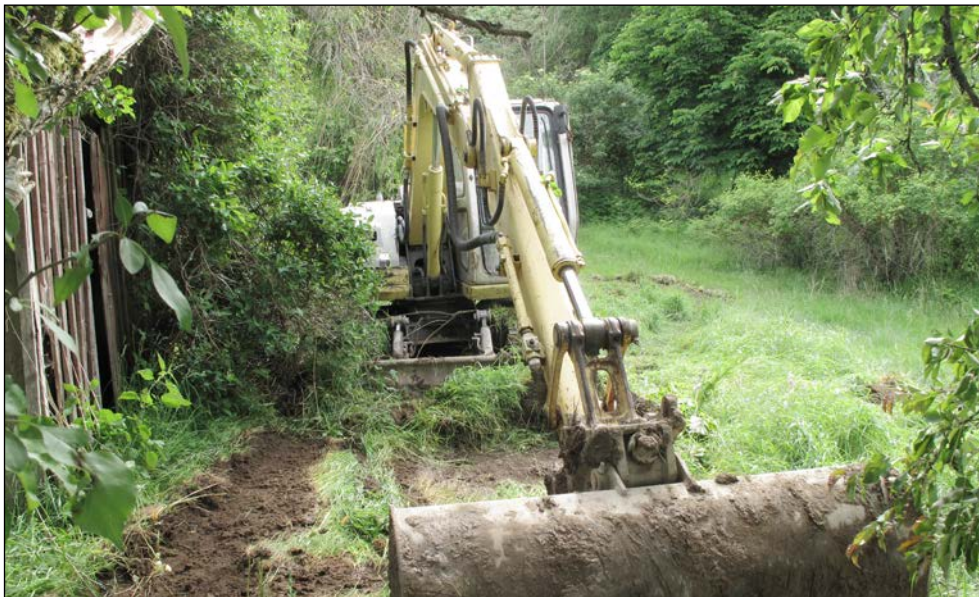
Figur 8. Schakt 2 grävs med maskin söder om hus 2.
