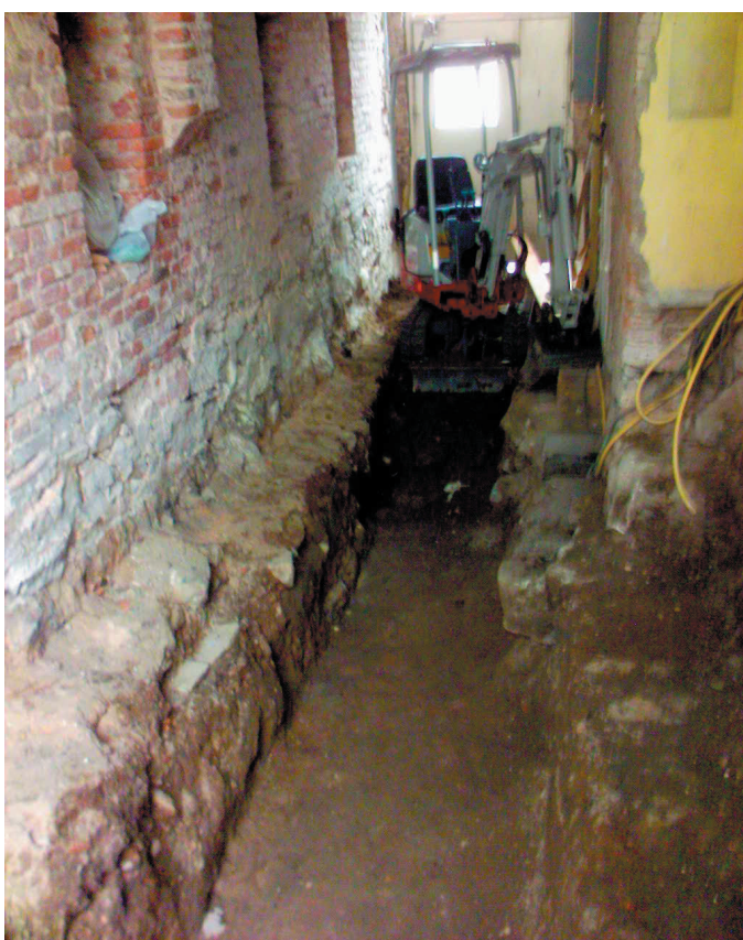
Fig. 5. Fjärrvärmeschaktet. Den vänstra profilväggen finns som profil. Bakom grävmaskinen ligger porten till fastigheten. Foto mot VSV.
