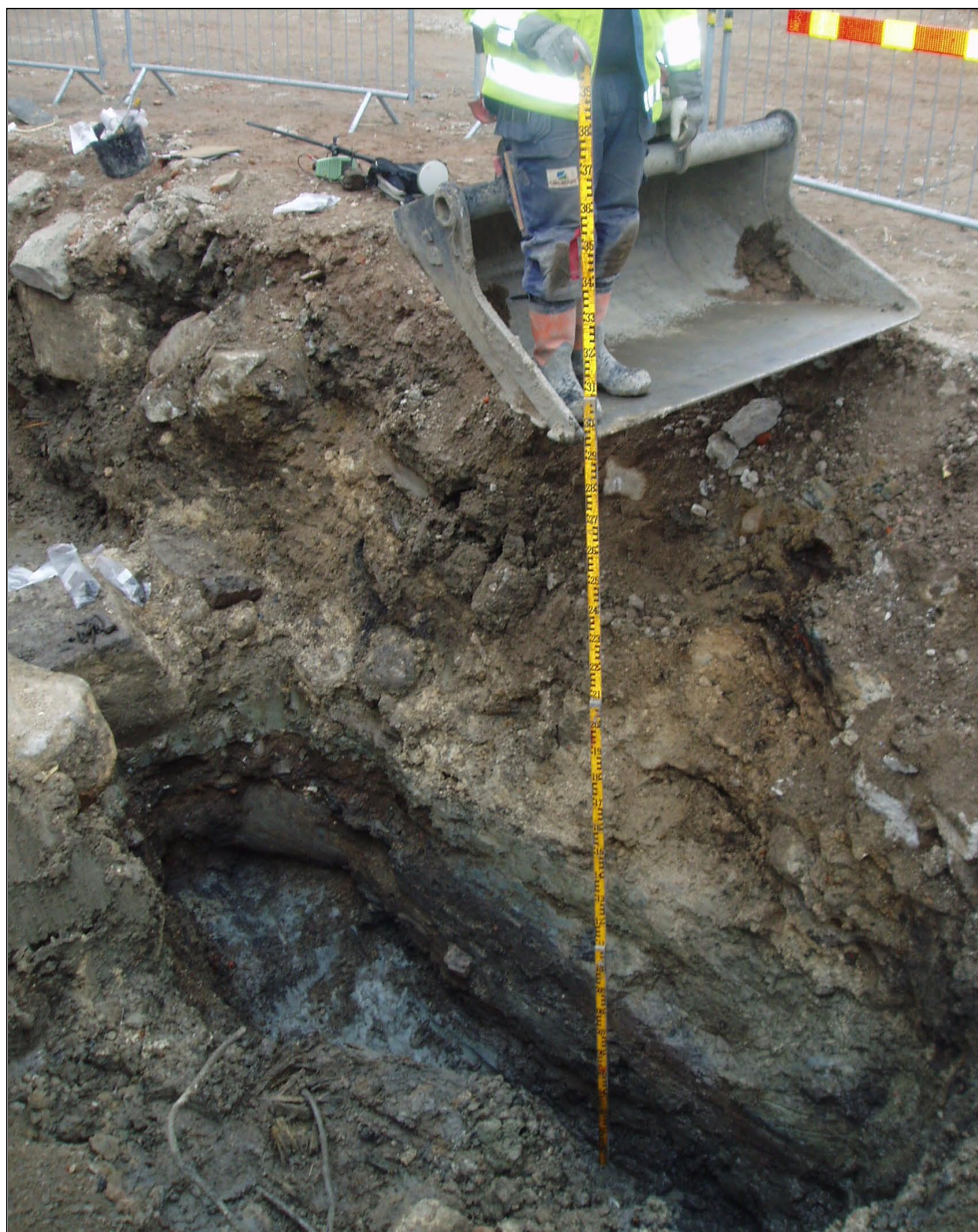
Figur 13. Djupschakt i schakt 2 mot NV. Foto: Tom Wennberg.
