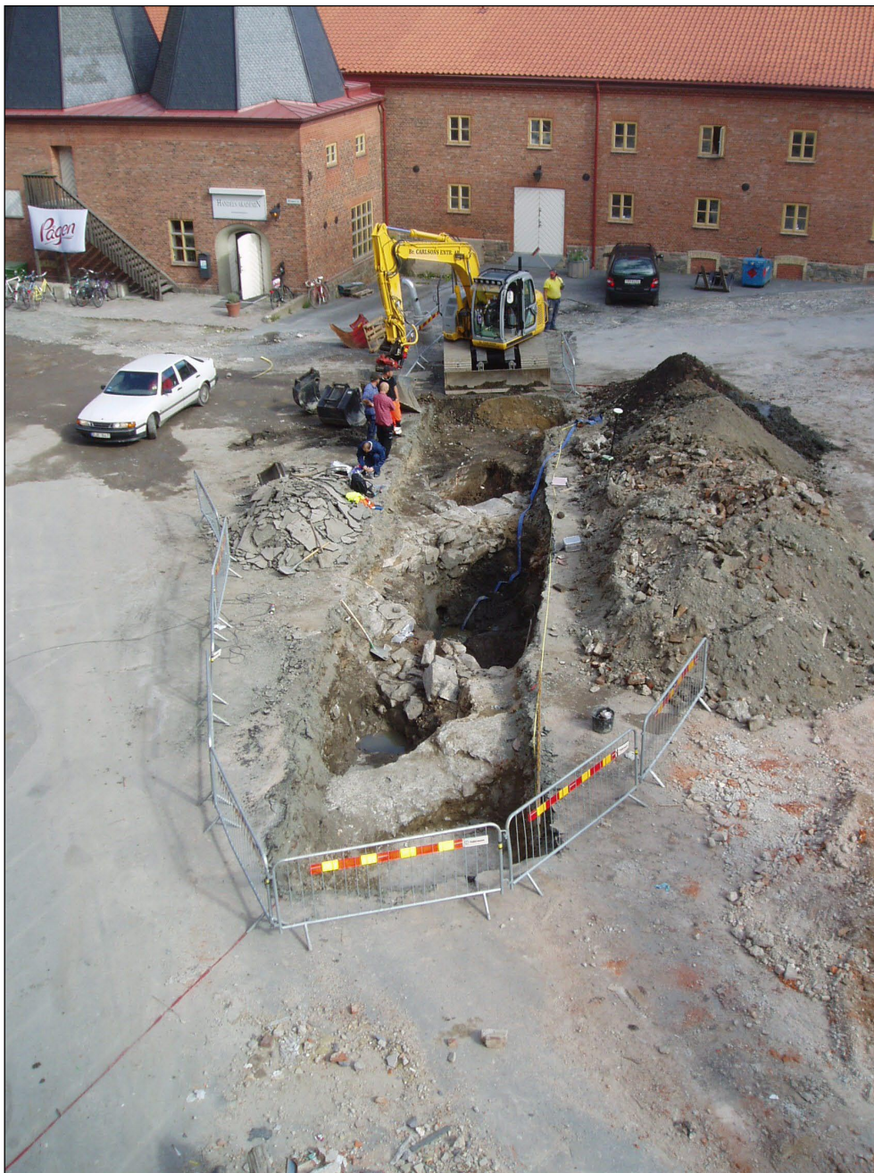
Figur 10. Översiktsbild över schakt 1 mot O. Foto: Tom Wennberg.
