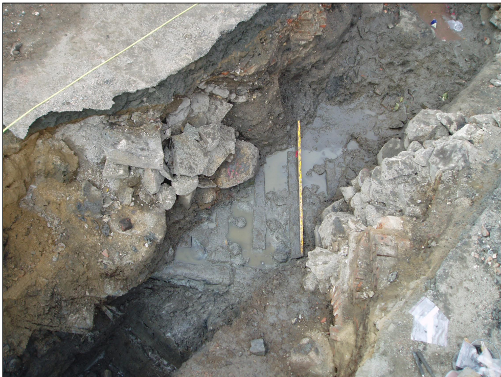
Figur 9. Lodfoto över mur 2 i schakt 1. Muren är delvis bortgrävd och rustbdden framrensad. Foto: Tom Wennberg.
