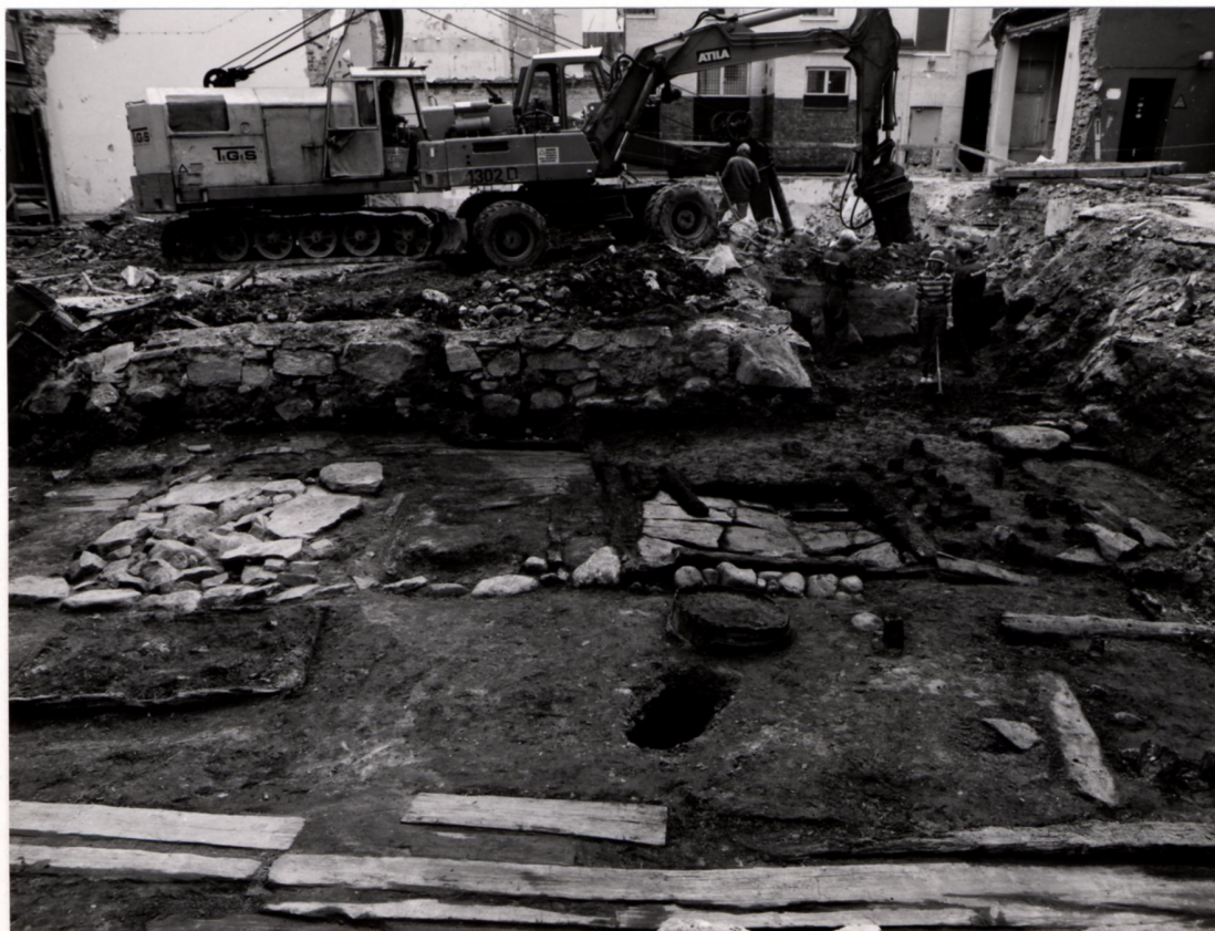
Fig 2. Foto: Lars Noord Kv Gamla Teatern. Schaktmassorna grävdes bort med hjälp av grävmaskinen.
