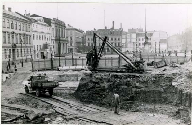
GRÄVNINGSGRÄVNINGENS SÖ. DEL.
