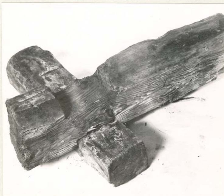
TRÄBYGGNAD "D" SÖ. KNUTEN. DE UNDERSTA STOCKARNA.
