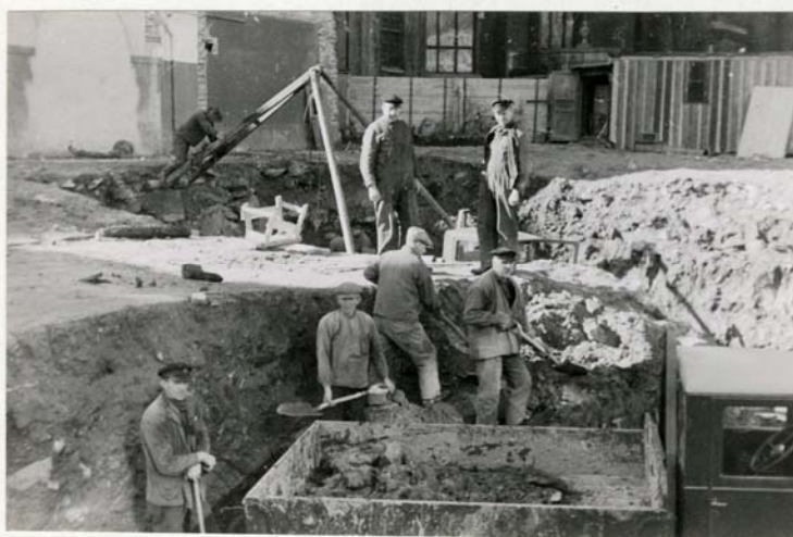
SCHAKTNING I MELLERSTA S. DELEN.
