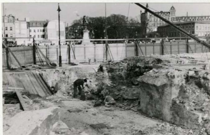
GRÄVNINGSGRÄVNINGENS NÖ. DEL.
