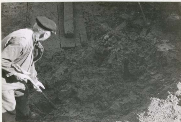
RUSTBÄDD "B" UNDER FRAMGRÄVNING. R. 88:26
