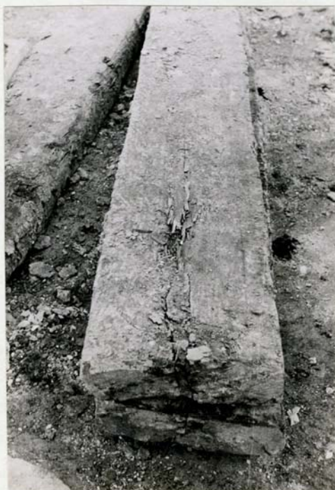
RUSTBÄDD "L". PLANKOR AV EK LÖPANDE I N-S.
