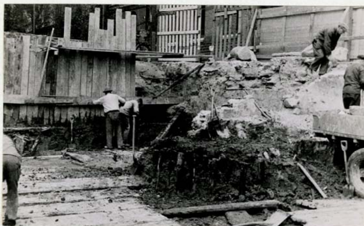
RUSTBÄDD Ö. OM "D" ARBETARNA I MITTEN STÅ VID HUSGRUND.
