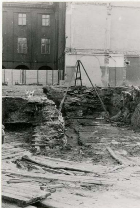
GRÄVNINGSGRÄVNINGENS MELLAN- LÖST DEL MOT S. I MELLANPLANET RUSTBÄDD "B".
