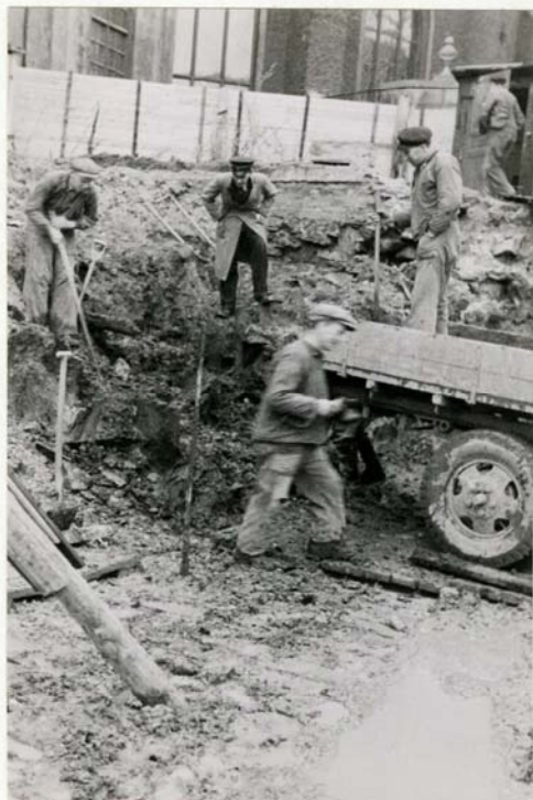
BRUNN IV UNDER FRAM - R.88:9 GRÄVNING. FR. NO.
