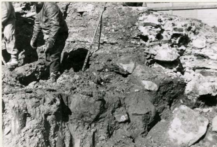
RUSTBÄDD "H" UNDER FRAMTAGNING. R. 85:10
