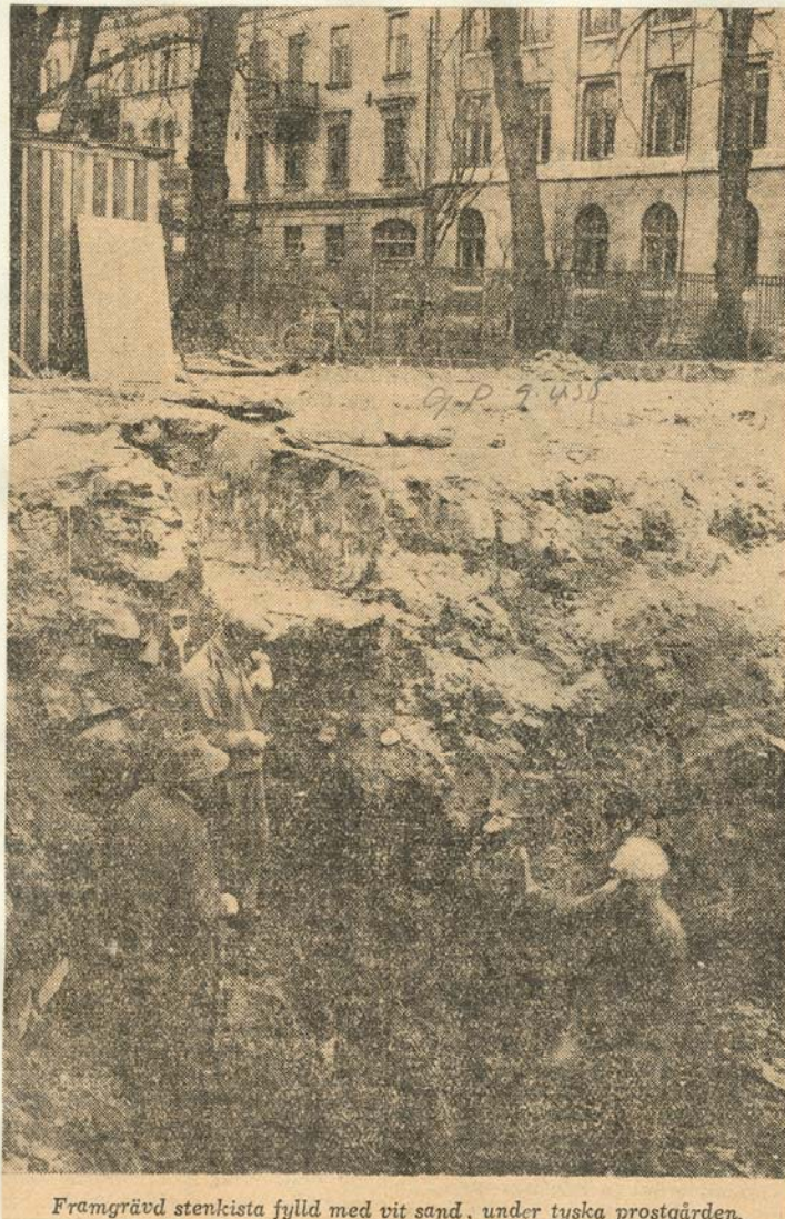
Framgrävd stenkista fylld med vit sand, under tyska prostgården.
