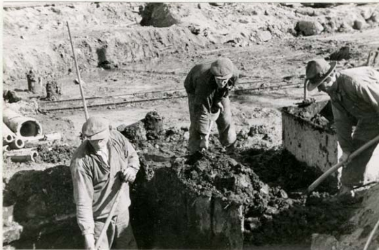
BRUNN NR III UNDER UTGRÄVNING.
