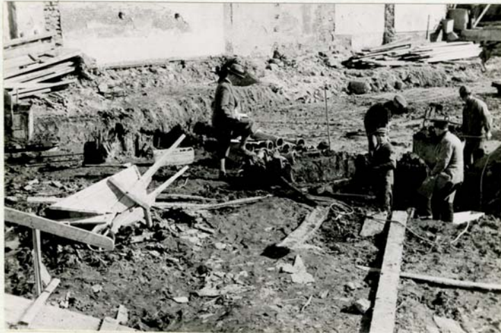
BRUNN NR. III UNDER UTGRÄVNING
