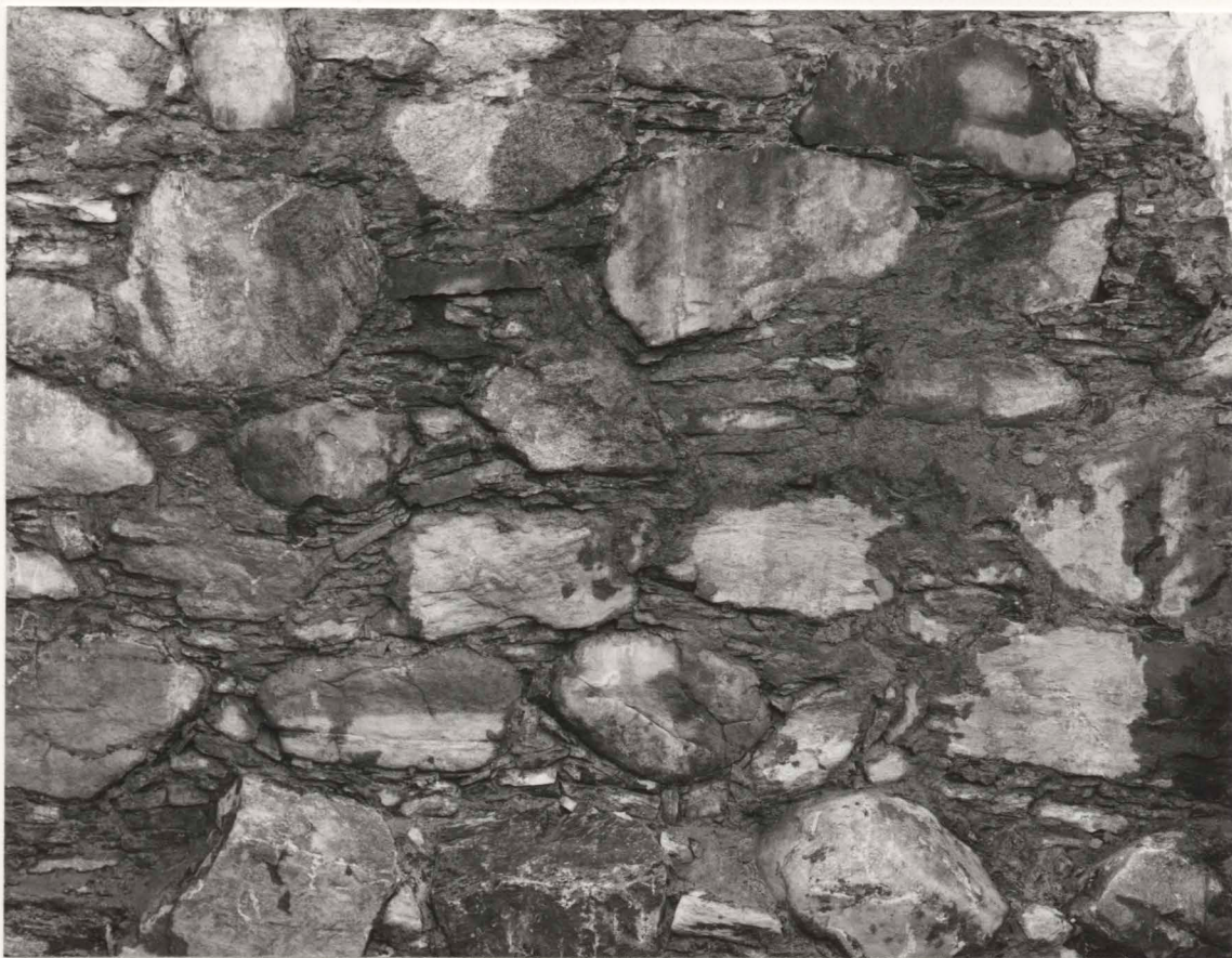
Fig 9. Kv Slusskvarnen. Murningsteknik.
