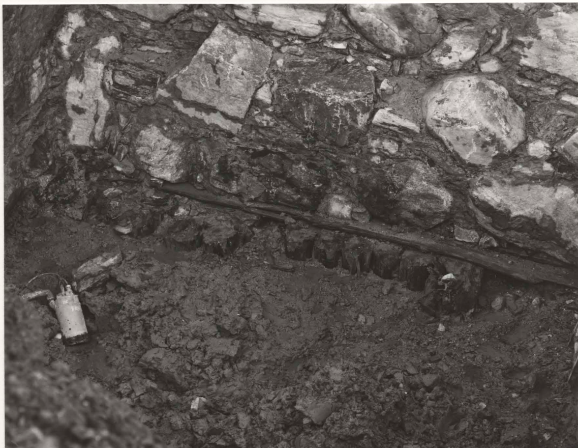
Fig 17. Foto: Lars Noord Kv Slusskvarnen. Mur och rustbädd där pålskallarna syns.
