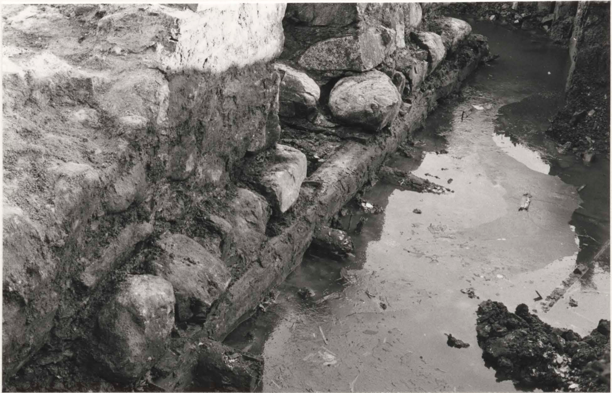
Fig 12. Foto: M Lorentzson Kv Slusskvarnen. Mur, sula och rustbädd.
