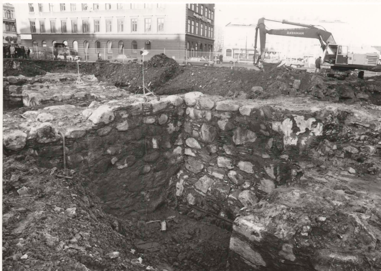
Fig 21. Foto: Lars Noord Genomgrävning av kasemattrummet ner till rustbädden, mot norr.
