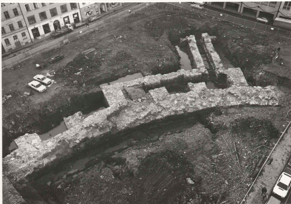
Fig 6. Foto: Lars Noord Kv Slusskvarnen. Översiktsbild mot söder.
