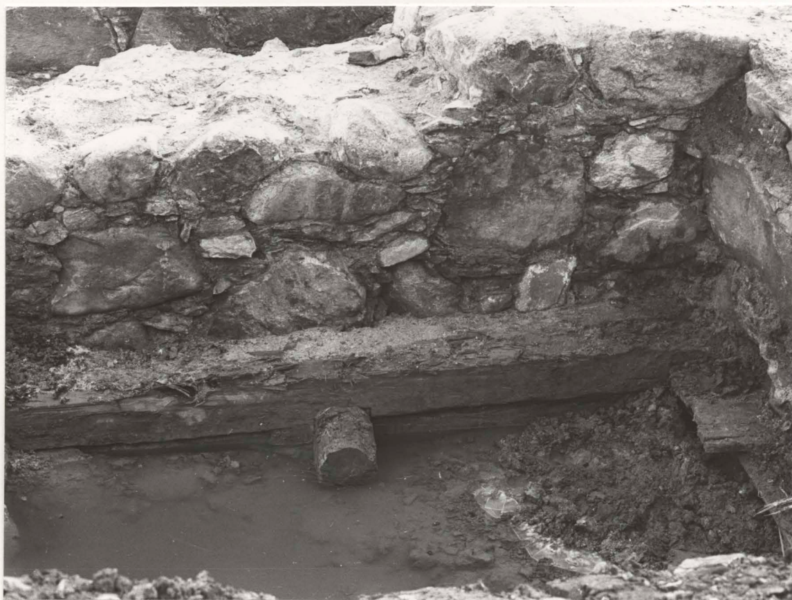
Fig 18. Foto: M Lorentzson Kv Slusskvarnen. Mur och rustbädd.
