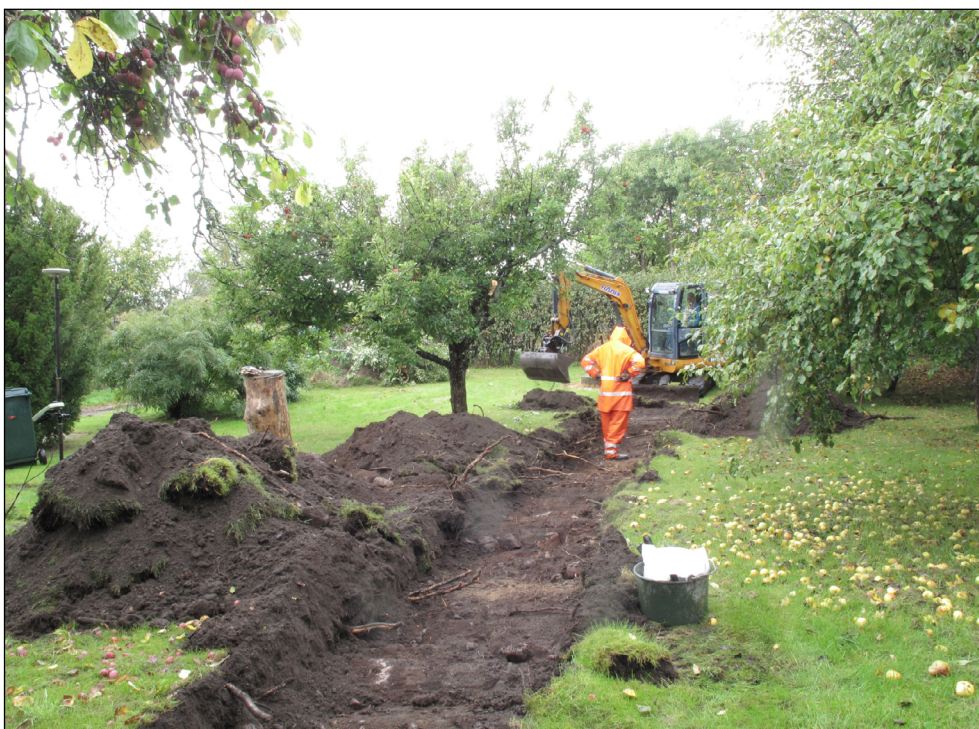
Figur 15 (nedan). Ett långschakt (schakt 6) grävdes på fastighetens nordöstra del. Ulf Ragnesten i bild. Foto mot norr.
