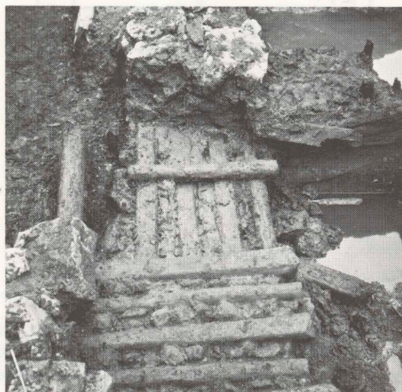
Fig 5. Neg. nr. B 10283 Tomt C, skede 3. Rustbädd till stengrund lagd av omväxlande stockar och stenar.
