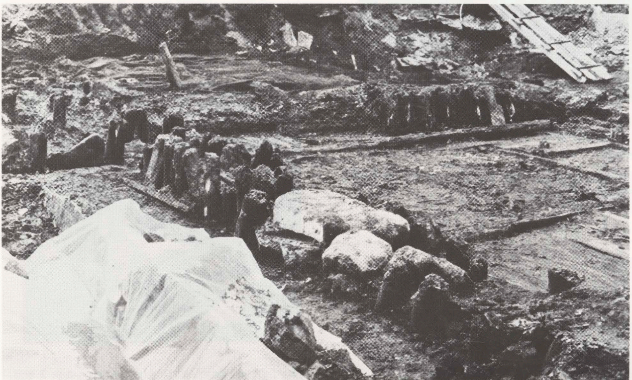
Fig 20. Pålning till stenmur mellan tomterna B och C. Mot nordöst. Piling for stone wall between sites B and C. Facing north-east..
