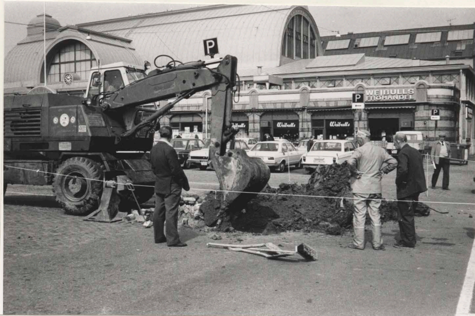
Fig. 3. Provgrop II. Översikt mot nordväst.
