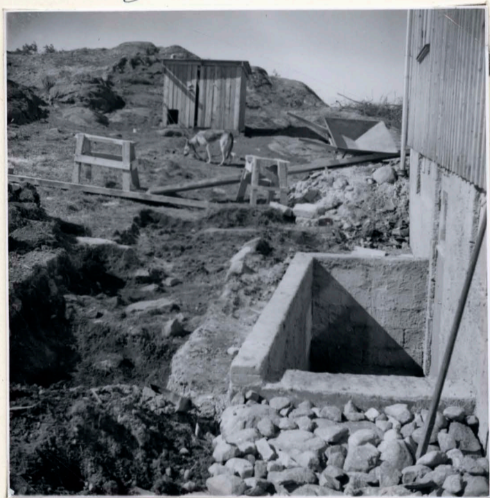
B 3115 Efter plåt n:r a 2242. Fält II, södra delen. Matjord avtäckt. Från NO.
