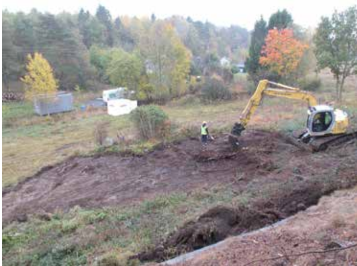
Figur 11. Den nordöstra sluttningen av sadeldalen på boplatsytan avbanades med maskin ned till fynd- och anläggningsnivå. Foto mot sydost.
